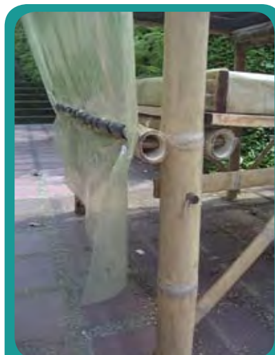
Figura 13. Sujeción del plástico en la pasera de cuerpos.
