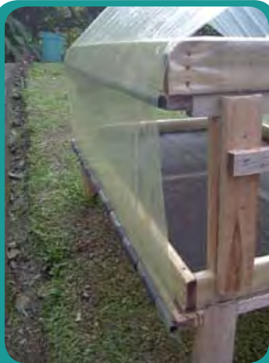
Figura 11. Sujeción del plástico en la pasera simple.
