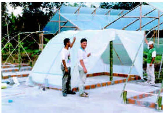
Figura 2. Prototipo de un secador solar parabólico modificado de tipo experimental. Obsérvese el plástico enrollado y sobrepuesto a la muselina en los extremos. La orientación longitudinal debe estar en la dirección cardinal Norte - Sur, para aprovechar al máximo la radiación solar.
