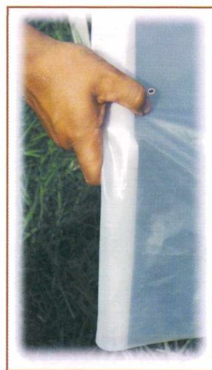
Figura 12. Sistema de templeado del plástico en las latas de guadua.
