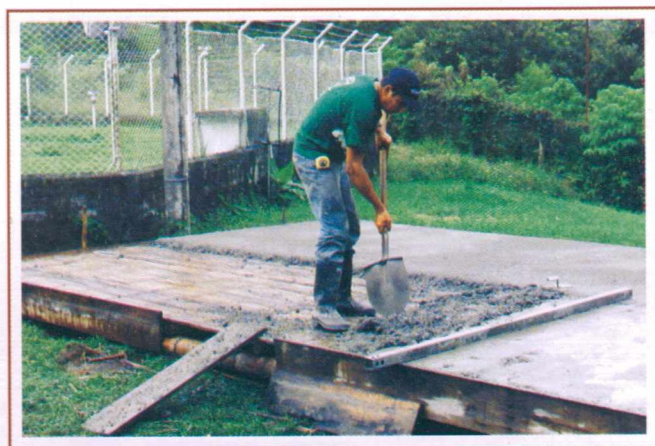
Figura 8. Placa del piso en concreto 1:2:4. Acabado fino y liso con paleta o llana.
