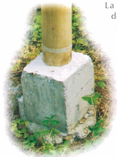
Figura 4. Columna en guadua revestida en concreto.
