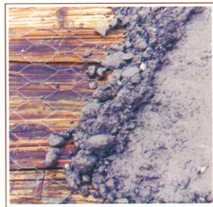
Figura 7. Concreto reforzado con malla de gallinero de 2",
