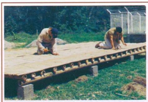
Figura 6. Piso en entramado de guadua, con esterilla.
