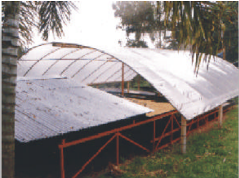
Figura 6. Carros secadores de café con cubierta plástica construida con guadua.
