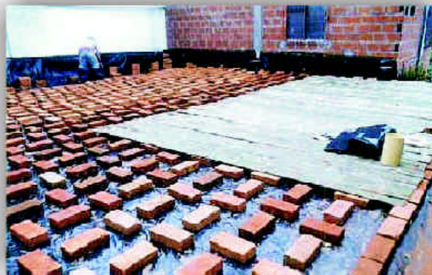
Figura 4. Se colocaron las hileras sueltas de ladrillos de arcilla para soportar el piso de esterillas en tendido doble cruzado
