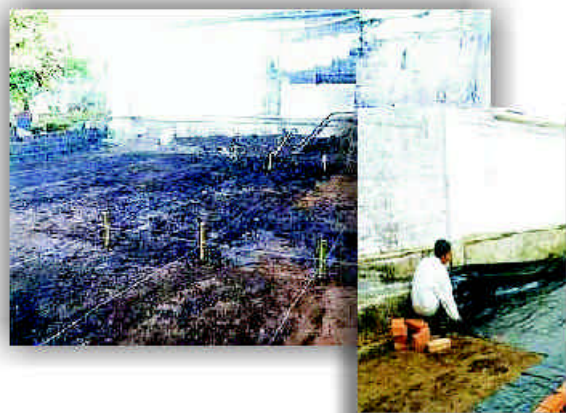
Figura 2. Preparación del terreno en el acondicionador de pulpa. Impermeabilización del piso con plástico agrolene
