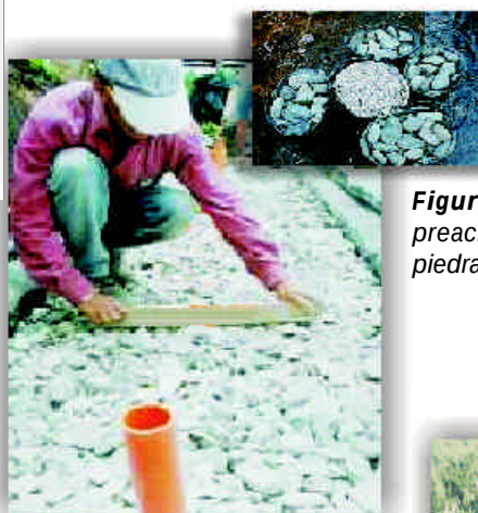
Figura 12. Lecho de Secado. Descarga de lodo proveniente de la Unidad de Control de Insolubles
