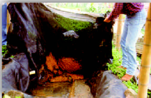
Figura 12. Lecho de Secado. Descarga de lodo proveniente de la Unidad de Control de Insolubles
