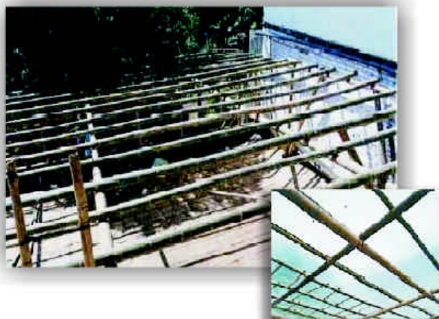
Figura 6. Guadua utilizada en la construcción del techo del AP.
