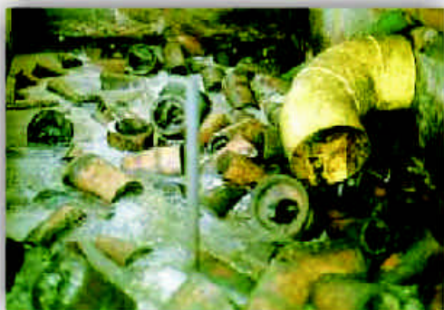
Figura 8. Unidad de control de insolubles en operación. Los trozos de guadua aceleran la hidrólisis y la acidogénesis.
