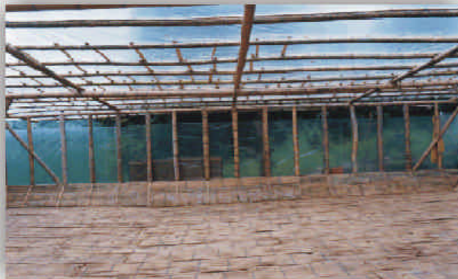
Figura 5. Interior de AP. Techo y paredes en plástico para producir efecto invernadero.
