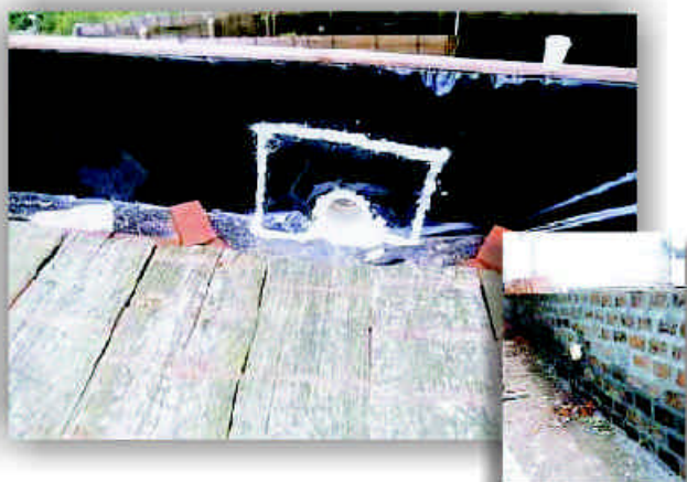
Figura 3. Salida de lixiviados y entrada de aire seco a través de tubería PVC 6"
