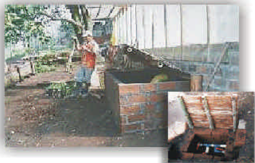
Figura 7. Unidad de Control de Insolubles. Válvulas para control de salida de fluidos.
