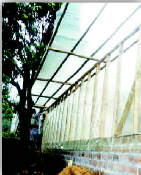
Figura 1. Acondicionador de pulpa de café. Se observa el vuelo exterior del techo de 1,50cm de ancho
