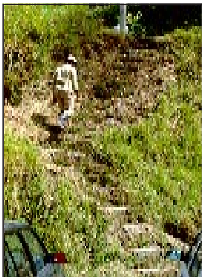
Figura 3. Escalinatas hechas con escombros de construcción.
