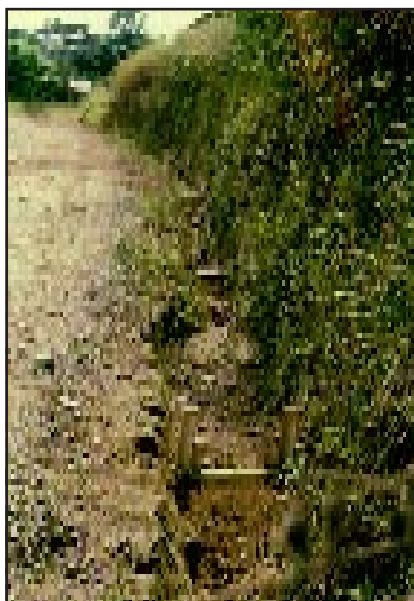
Figura 6. Trinchos utilizados para evitar el socavamiento de cunetas.
