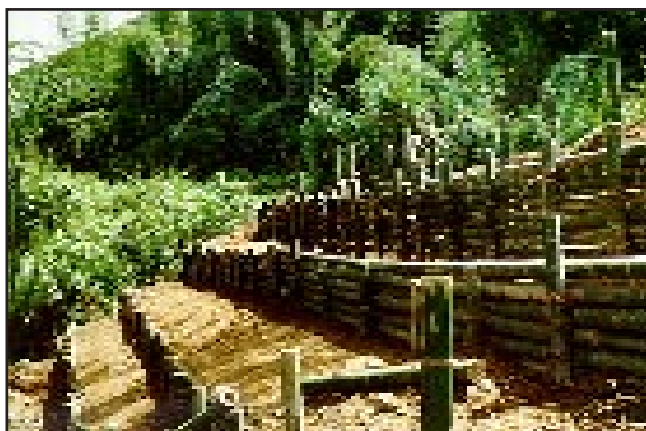
Figura 14. Construcción de terrazas escalonadas en tierra, para conformar parte de la banca perdida como consecuencia de negativo de carretera. Cenicafé, Chinchiná, Caldas, septiembre de 1995.
