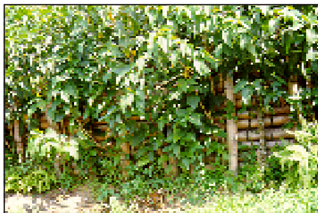
FIGURA 13. Trinchos reforzados con quiebrabarrigo o nacedero.
