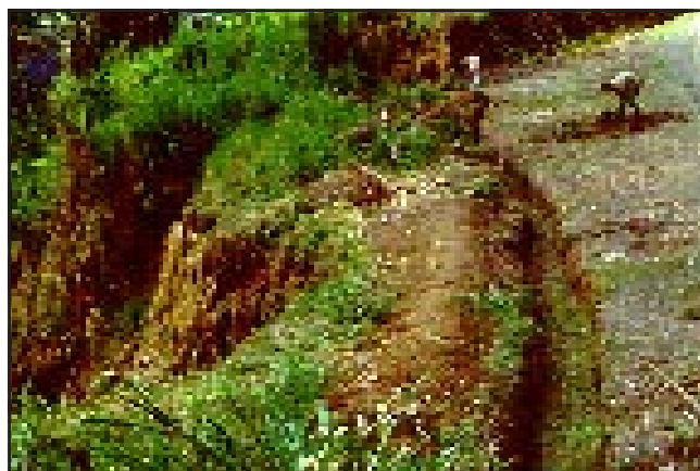
Figura 11. Canal de corona con cobertura de pastograma ( Paspalum conjugatum ) para desviar flujo de agua por escorrentía en el control de negativo de carretera. (Cenicafe, Chinchiná, diciembre de 1993).
