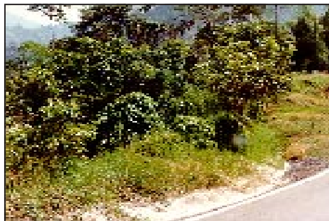
Figura 15. Recuperación definitiva de negativo de carretera. Se observa el cubrimiento total de las terrazas con vegetación multistrata. Cenicafé, Chinchiná, Caldas, marzo de 1997.
