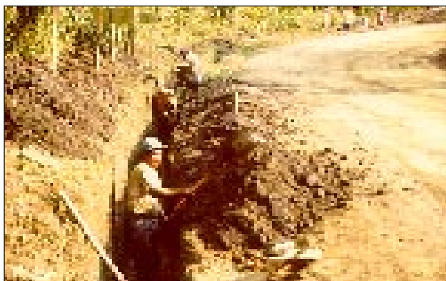
Figura 4. Obras de drenaje para evacuar aguas subsuperficiales.
