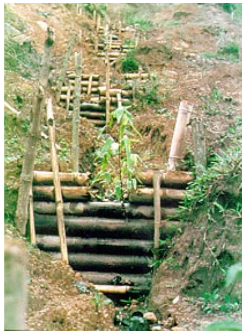
Figura 7. Evacuación de aguas superficiales mediante trinchos escalonados en guadua ( Guadua angustifolia ). Obran como disipadores de energía. Fincas Providencia y La Aurora (Palestina Caldas).
