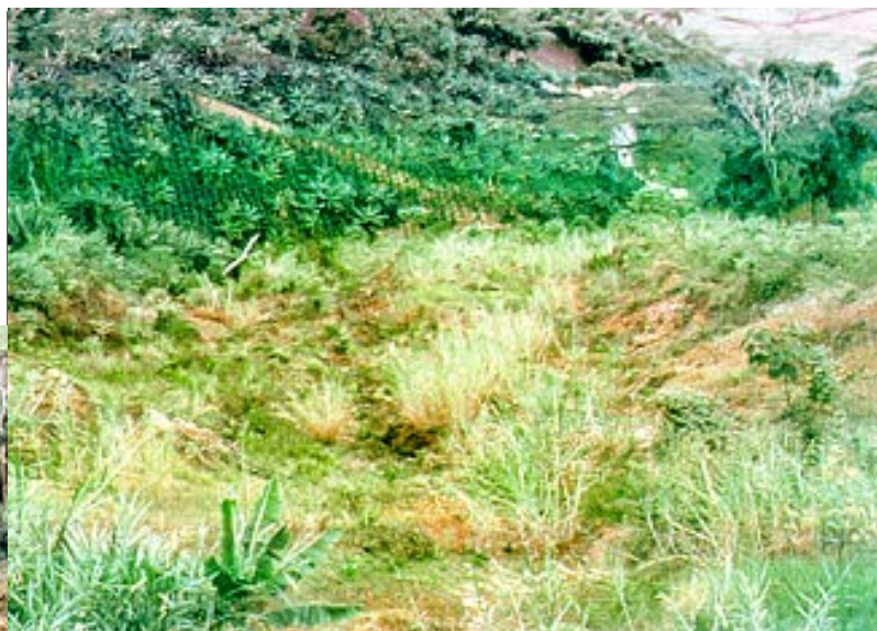
Figura 9. Recuperación de Cárcava remontante en fincas providencia y La Aurora en Palestina Caldas. Unidad Chinchiná, Melanudands. Construcción de trinchos escalonados vista desde arriba hacia abajo (Octubre de 1994).
