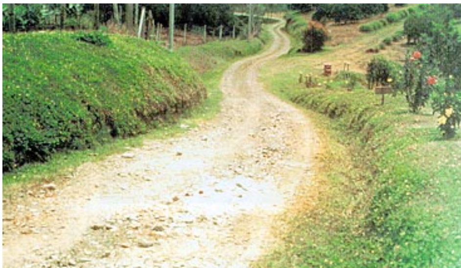
Figura 4. Cuneta protegida con cobertura densa de maní forrajero ( Arachis pintoi ), Subestación de experimentación de Cenicafé, La Catalina (Pereira, Risaralda).
