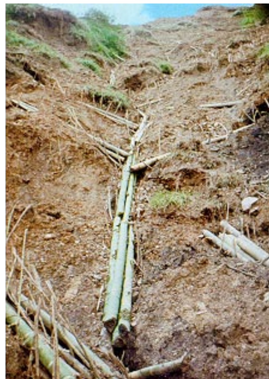
Figura 5. Construcción de filtro vivo en espina de pescado, usando guadua ( Guadua angustifolia )
