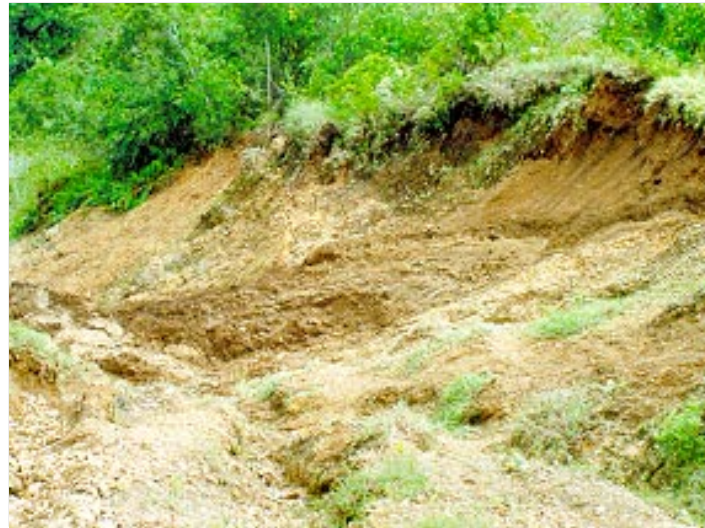
Figura 1. Cárcava remontante en estado avanzado.
