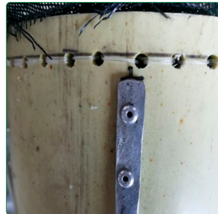
Figura 14. Sujeción del gancho al tubo PVC.
