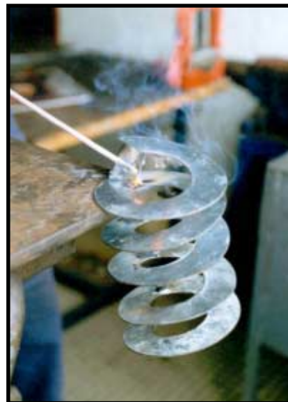
Figura 7. Unión de los discos con soldadura eléctrica
