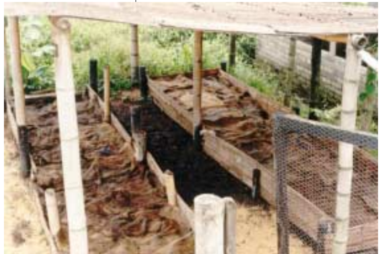
Figura 1. Camas hechas en guadua y con techo construido con el mismo material y tejas de cartón, en la Fundación Manuel Mejía en Chinchiná, Caldas.
