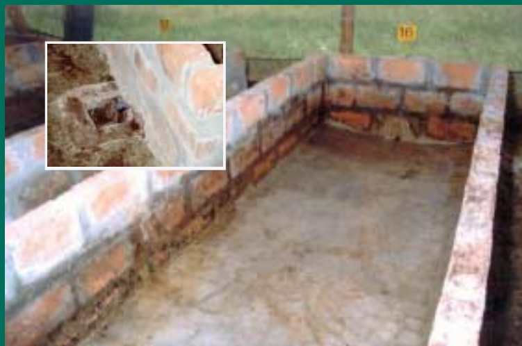
Figura 4. Cama en ladrillo: obsérvese el piso de cemento, con desnivel y desagüe.
