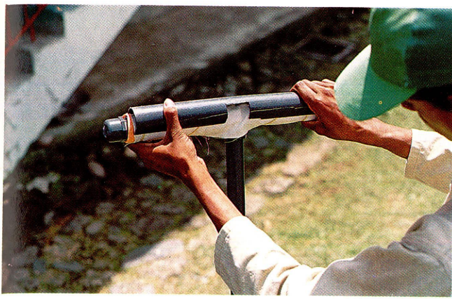
Figura 15. Se coloca el protector sobre la lona del tubo aplicador.
