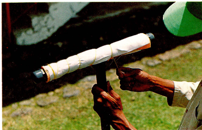
Figura 8. Se cubre el tubo perforado con una lona, que se amarra fuertemente.
