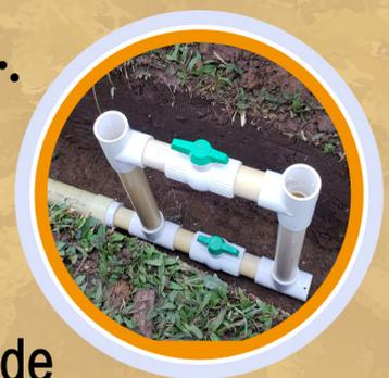
Tubería de aireación y drenaje
