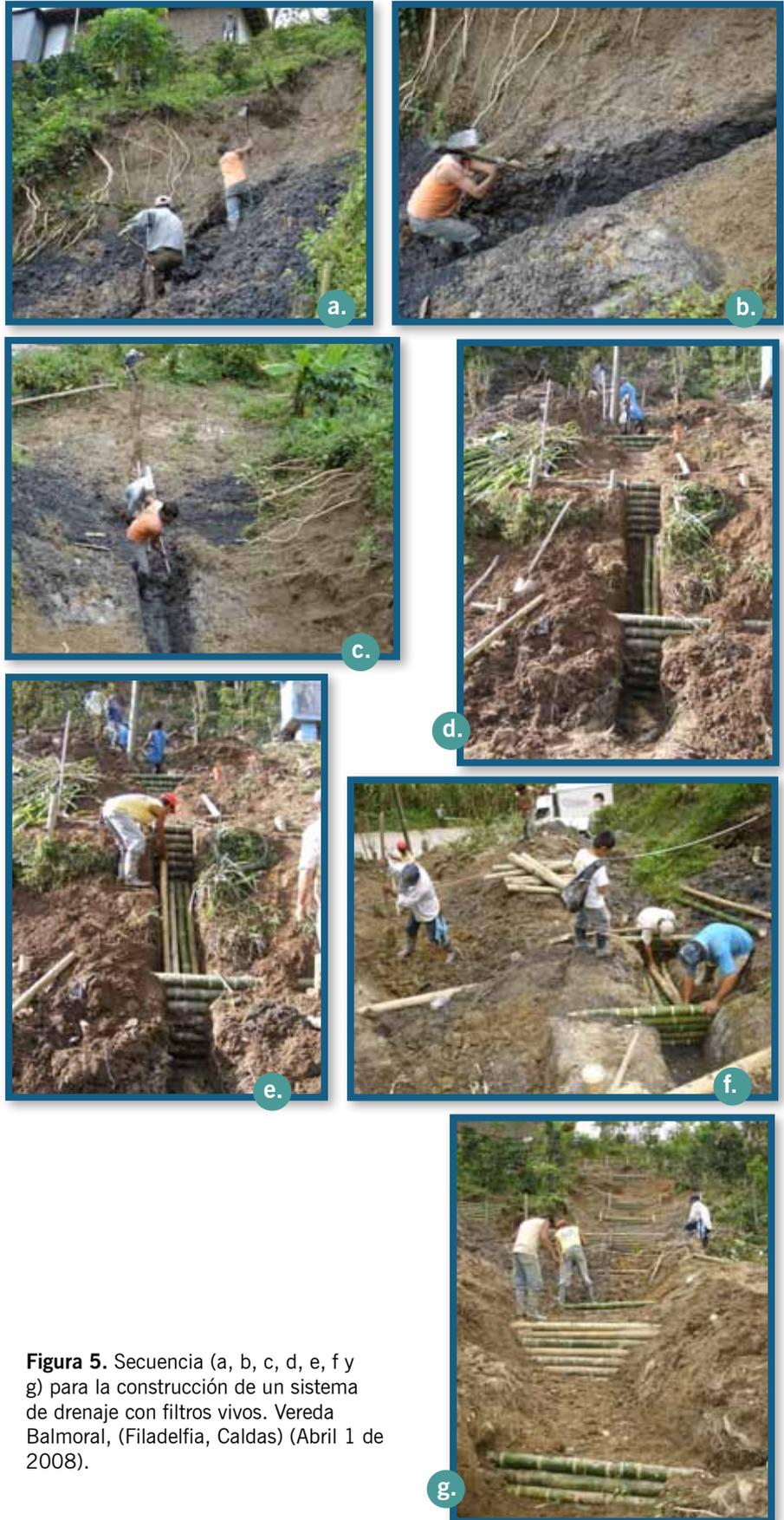
**Figura 5.** Secuencia (a, b, c, d, e, f y g) para la construcción de un sistema de drenaje con filtros vivos. Vereda Balmoral, (Filadelfia, Caldas) (Abril 1 de 2008).
