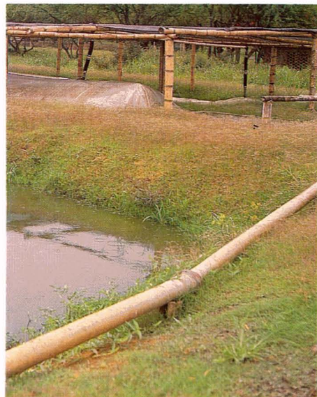
El biodigestor además de producir gas, produce bioabono que es conducido a estanques o cultivos.
