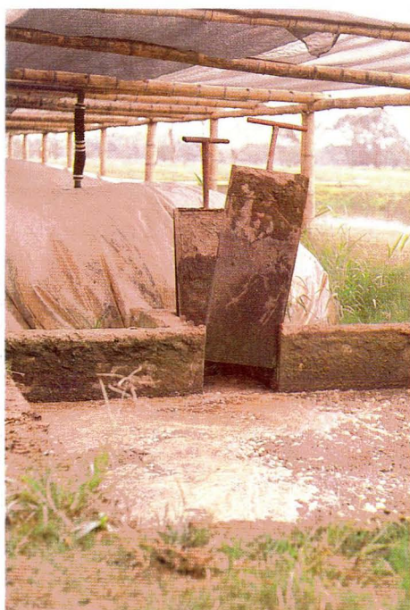
Caja de carga o entrada.
