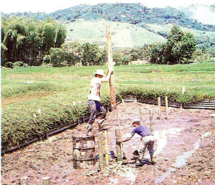
Como refuerzo a los taludes de los estanques, para evitar los derrumbes.
