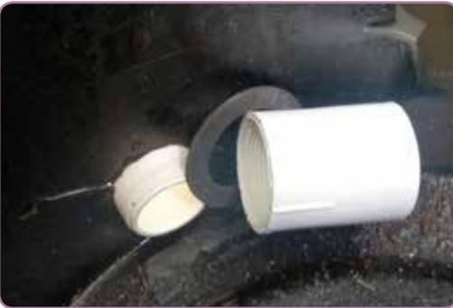
**Figura 76.** Acople del adaptador hembra.
