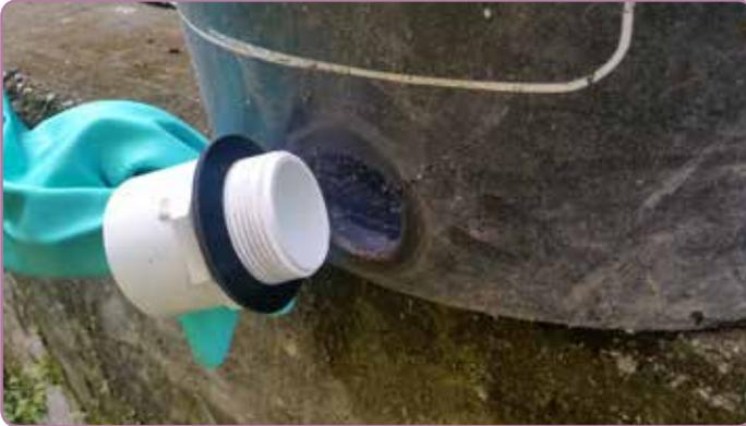
**Figura 75.** Acople del adaptador macho.
