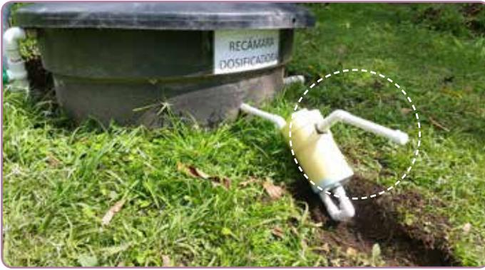
**Figura 36.** Acople de la tubería de salida de la trampa de sólidos.
