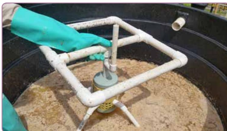
**Figura 87.** Levantamiento del dispositivo flotante para su mantenimiento.
