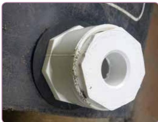
**Figura 80.** Acople de una reducción de  $\frac{1}{2}$ " al adaptador macho.
