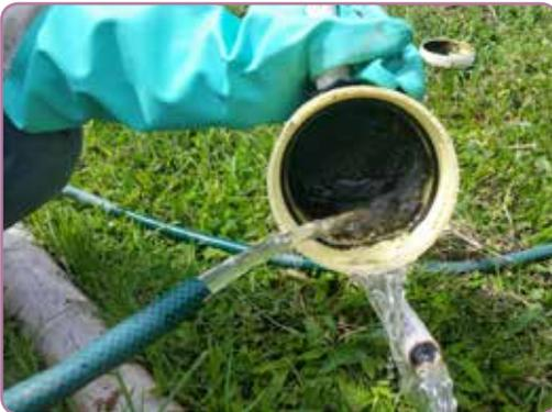
**Figura 42.** Lavado de la trampa de sólidos con agua limpia.
