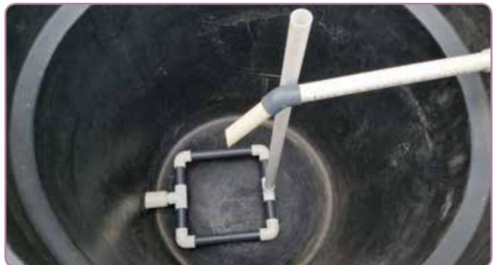
**Figura 48.** Dispositivo interno de limpieza del reactor metanogénico.
