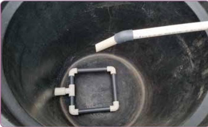
**Figura 46.** Marco de distribución del agua que ingresa al reactor metanogénico.
