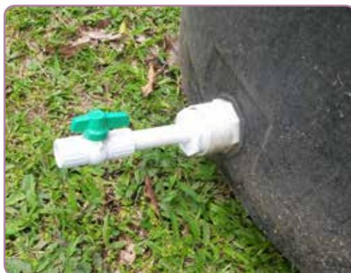
**Figura 81.** Instalación de una llave de paso antes de acoplar la trampa de sólidos.
