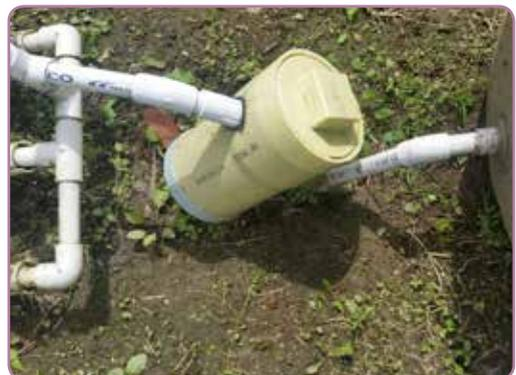
**Figura 45.** Trampa de sólidos acoplada de nuevo al tanque.
