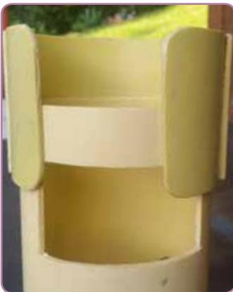
**Figura 54.** Acople de la tapa de la mirilla al tubo.
