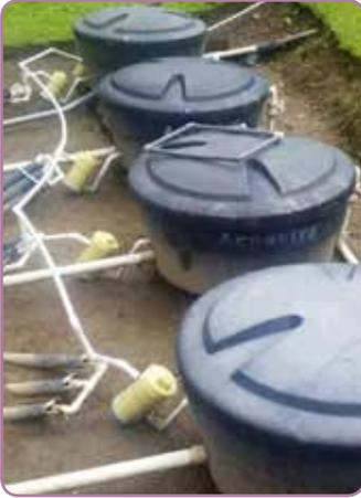
**Figura 38.** Trampa de sólidos en funcionamiento en recámaras dosificadoras.
