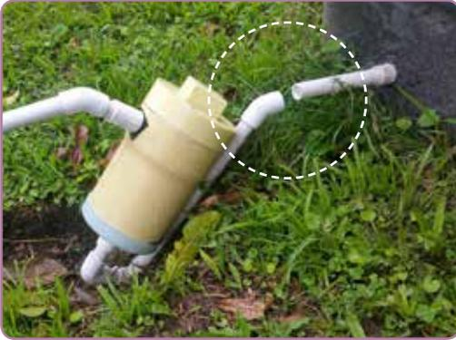
**Figura 40.** Desacople de la trampa de sólidos del tanque de polietileno.
