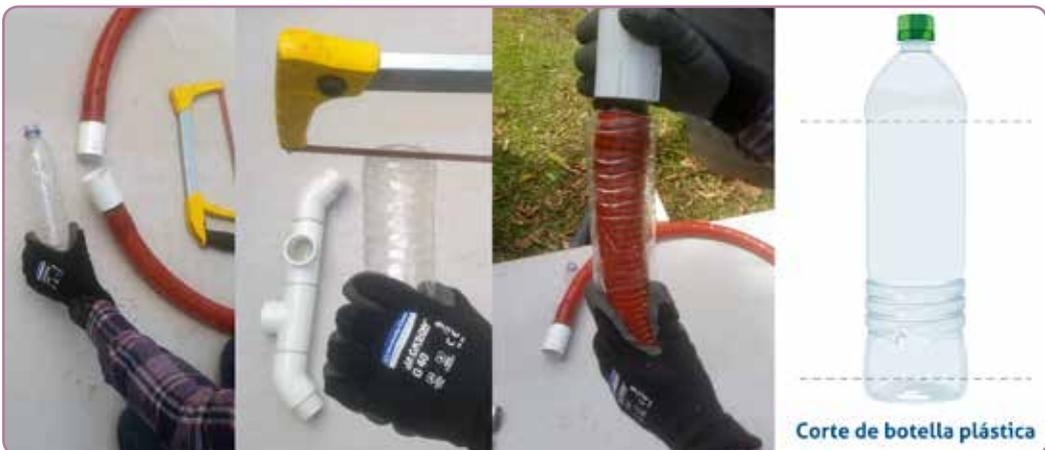
**Figura 19.** Corte y acople de los trozos de botella.
