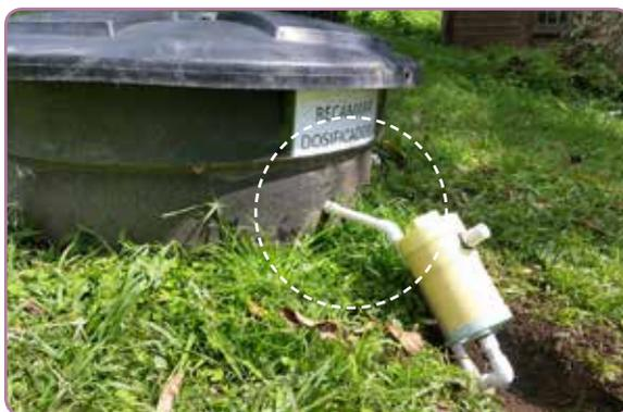
**Figura 34.** Acople de la trampa de sólidos a la recámara dosificadora.
