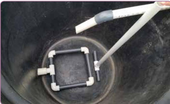
**Figura 47.** Reemplazo de uno de los lados del marco de distribución del agua de ingreso al reactor metanogénico, por una "T" con sus respectivos tubos de acople a los codos.
