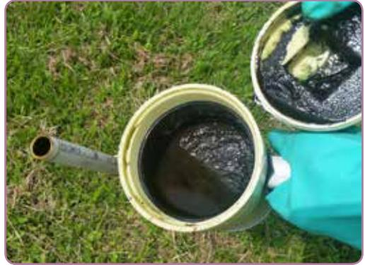
**Figura 41.** Desenroscado de la tapa de la trampa de sólidos.
