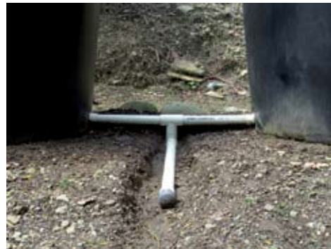
Figura 6. Conector de fondos y descarga de lodos de RHA.
