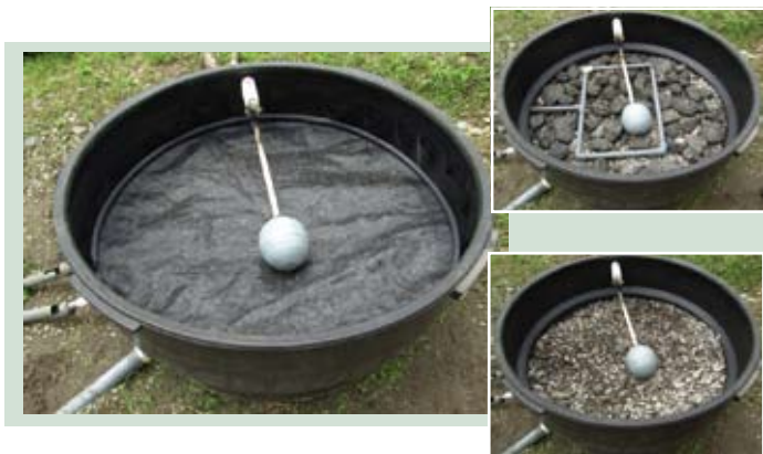
Figura 11. Acondicionamiento interior de la recámara de dosificación.
