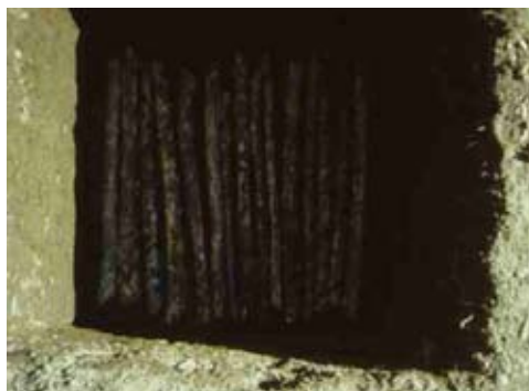
Figura 8. Excavación para rebose de ARL.
