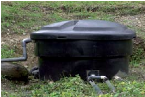
Figura 9. Recámara de dosificación en polietileno y 250 litros de capacidad.
