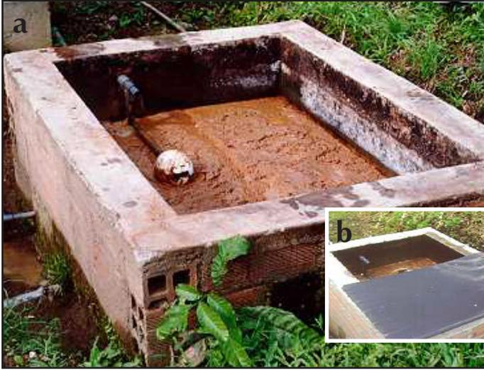
Figura 7. Recámara Dosificadora fabricada en ladrillos, cemento y arena (a); cubierta para reducción de malos olores (b).
