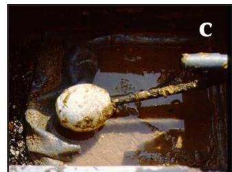
Figura 9. Componentes esenciales de la Recámara Dosificadora: a. Tapón de salida perforado; b. Colector de salida; c. Flotador y malla mosquitera.
