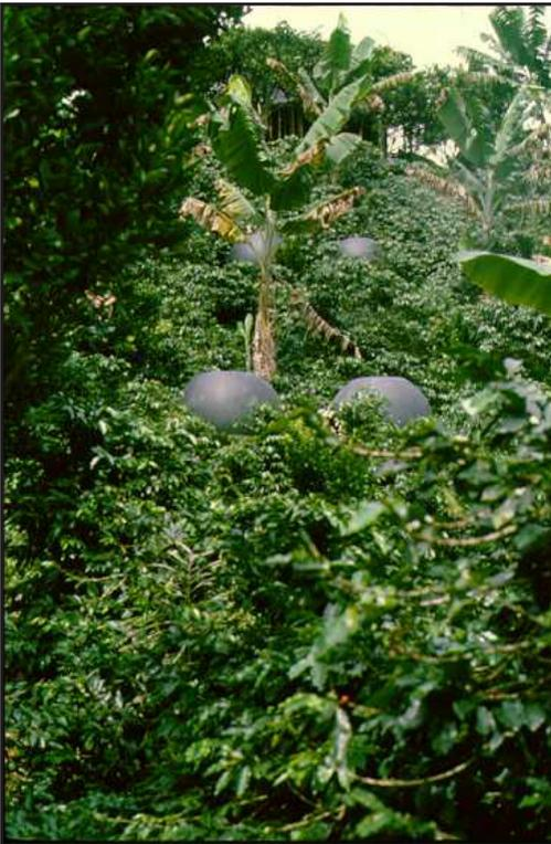
**Figura 1.** Prototipo inicial de planta de tratamiento de aguas residuales para fincas cafeteras, construido con tanques esféricos de asbesto cemento. Finca La Magnolia, municipio de Chinchiná.
