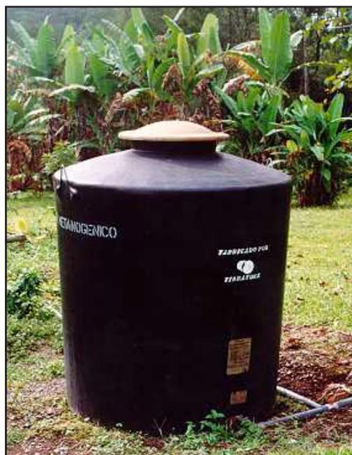
**Figura 10.** Tanque fabricado en fibra de vidrio, utilizado como reactor metanogénico.
