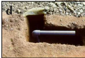
El primer metro del lecho a la entrada del líquido se llena con piedra caliza de 2,5cm de diámetro y los cuatro metros restantes con gravilla de río de 3cm de diámetro (Figura 19c). El líquido sale por el fondo del filtro mediante un codo y un tubo ascendente de PVC de
