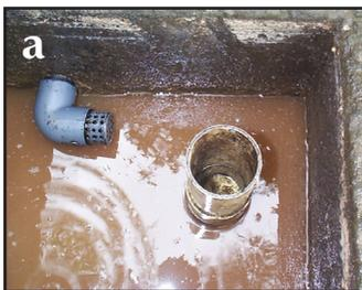
(Figura 3). La inclusión de válvulas antes de la recámara y del reactor metanogénico, permite suspender el flujo en caso de que sea necesario atender cualquier eventualidad que pueda presentarse durante la operación del SMTA, tal como la obstrucción de la tubería por la pulpa del café, palos y piedras, entre otros.
