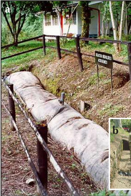
**Figura 4.** Biodigestor convencional fabricado en plastilona 500 y utilizado como infraestructura de Reactor Hidrolítico/ Acidogénico (a); Excavación del terreno para su instalación (b).
