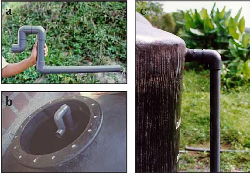
Figura 14. Dispositivo construido en tubería de PVC para la salida del agua residual tratada (a); ubicación dentro del Reactor Metanogénico (b); tubería de salida (c).
