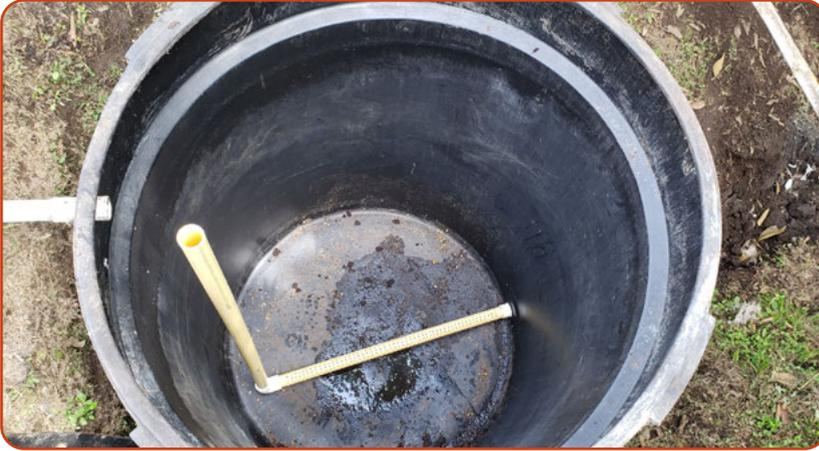
**Figura 34.** Instalación de la tubería de aireación y drenaje en la unidad de procesamiento de la biocama.
