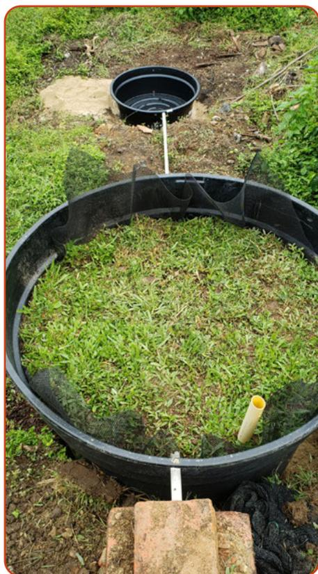
**Figura 48.** Instalación del tanque de recolección de drenados a la salida de la unidad de procesamiento de la biocama.
