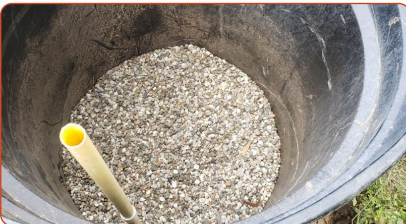
**Figura 36.** Cubrimiento de la tubería de drenaje con una capa de gravilla.
