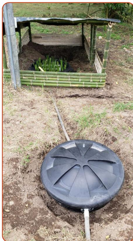
**Figura 49.** Instalación del techo en la unidad de procesamiento de la biocama.
