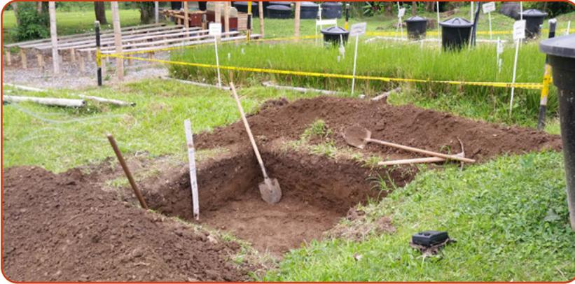
**Figura 7.** Excavación para implementar la unidad de procesamiento de la biocama.
