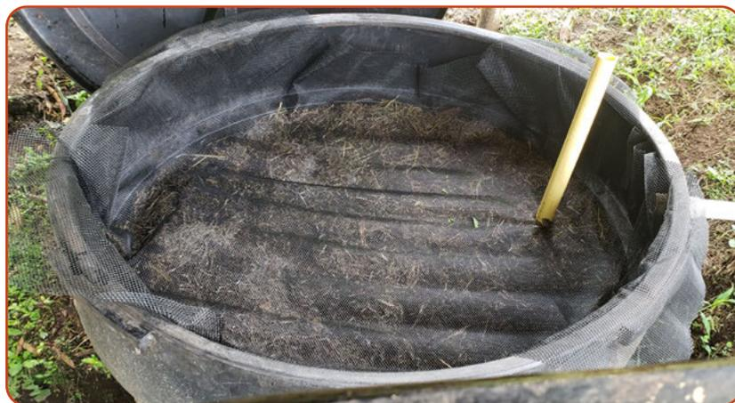
**Figura 42.** Malla plástica para separar las capas de biomezcla y de grama.
