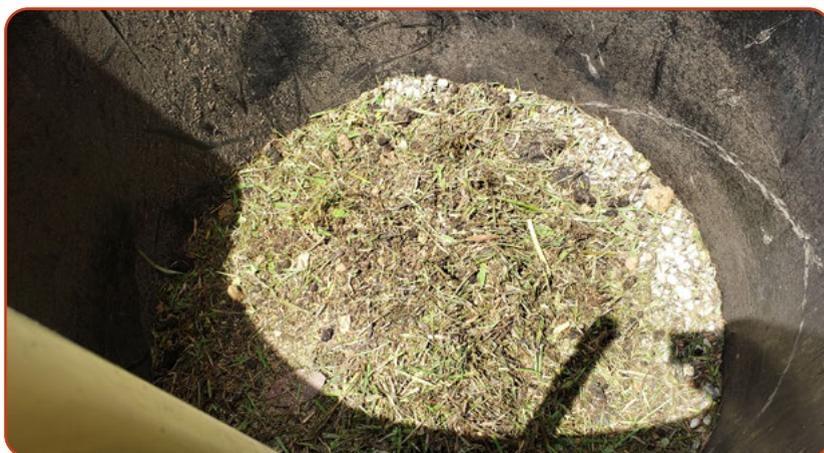
**Figura 37.** Adición de la biomezcla sobre la capa de gravilla en la unidad de procesamiento de la biocama.
