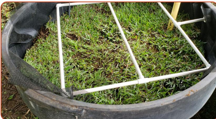
**Figura 47.** Instalación del sistema de distribución del agua residual sobre la capa de grama de la unidad de procesamiento de la biocama.
