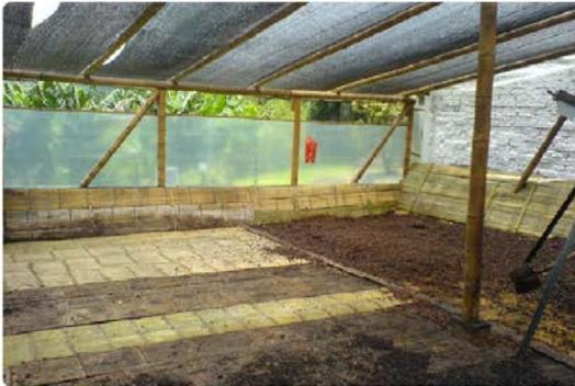
Instalar el falso piso en esterilla y con pendiente del 2% para recolectar lixiviados.
