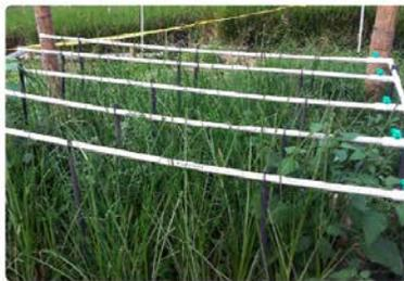
Conducir el agua pretratada al filtro verde a través de un sistema de riego por goteo, elevado por lo menos 1,5 m del suelo.
