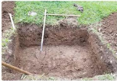
Realizar una excavación de 0,70 m de profundidad, en el área calculada, con una pendiente del 2,0%, hacia el centro y hacia la parte inferior.
