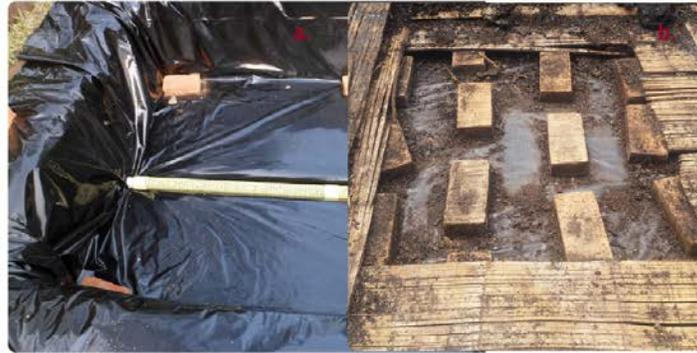
Impermeabilizar el suelo con plástico o geomembrana y colocar soporte para instalar un falso piso.
