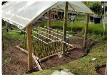
Construir una infraestructura tipo invernadero sobre el filtro verde para evitar el ingreso del agua lluvia y favorecer la evaporación del agua.
