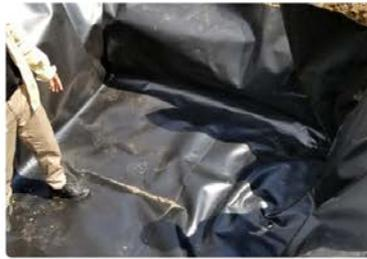
Impermeabilizar la excavación con geomembrana.
