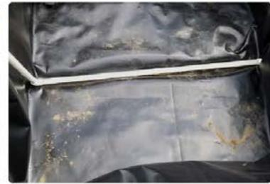
Colocar un tubo de PVC, en la parte central, con orificios distribuidos a lo largo del mismo para airear y permitir la salida de agua no retenida.
