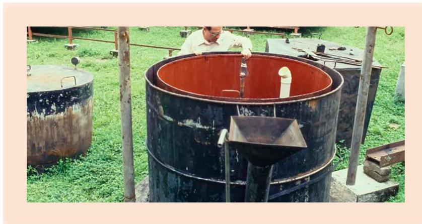
**Figura 43.** Aspecto de un biodigestor operando con pulpa de café.
