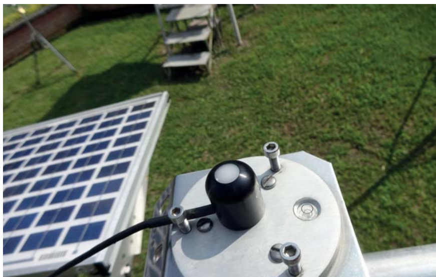
Figura 12. Piranómetro para medición de radiación solar.
