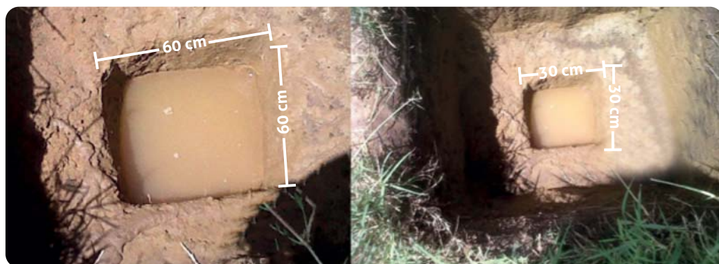
Figura 36. Ensayos de infiltración para el diseño de campos de infiltración.
