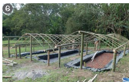
6 Construcción del techo para los lechos de secado
