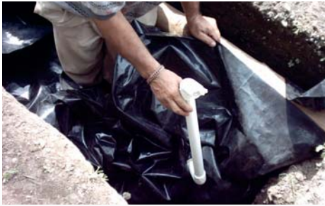
Dispositivo de salida de cada laguna (toma desde el fondo)
