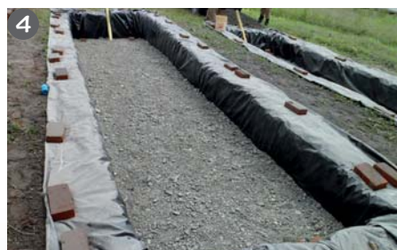
4 Adición de la capa de arena
