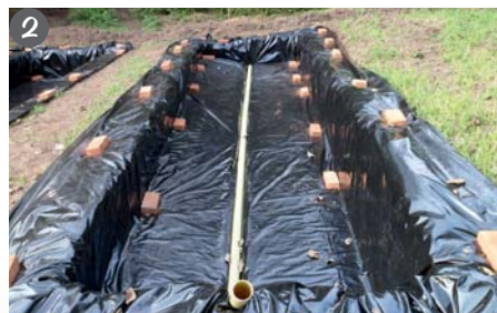
2 Impermeabilización de los lechos de secado
