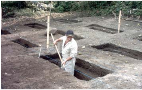
Trazado y excavación
