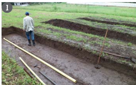
1 Excavaciones y ubicación de tubería de aireación
