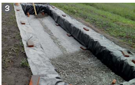
3 Adición capa de grava
