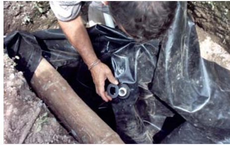
Ubicación del plástico y empaques de caucho
