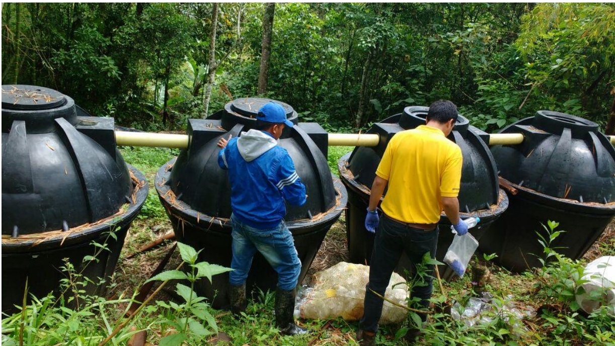
Modelo de los diseños de fosas de reúso para el manejo de la pulpa y de las aguas residuales del café y aspecto de uno de los sistemas de tratamiento de aguas residuales instalados en finca.
