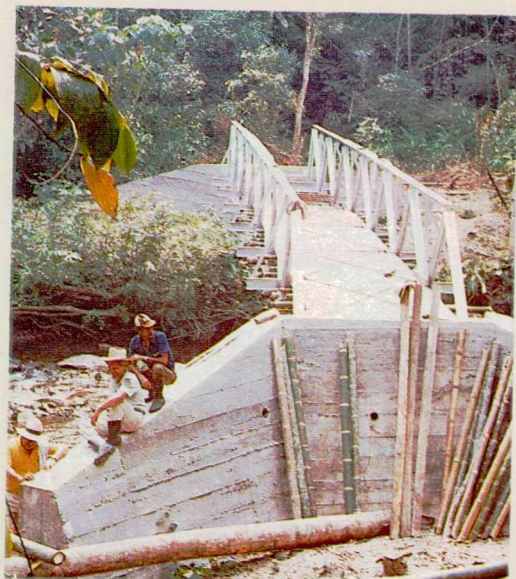
▲ Construcción de puente peatonal.
