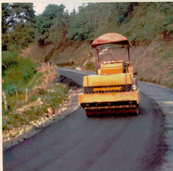
Pavimentación de la carretera La Trinidad - Chinchiná.
