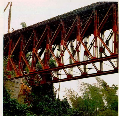
Puente sobre la quebrada "El Rosario". Vía La Trinidad - Chinchiná.
