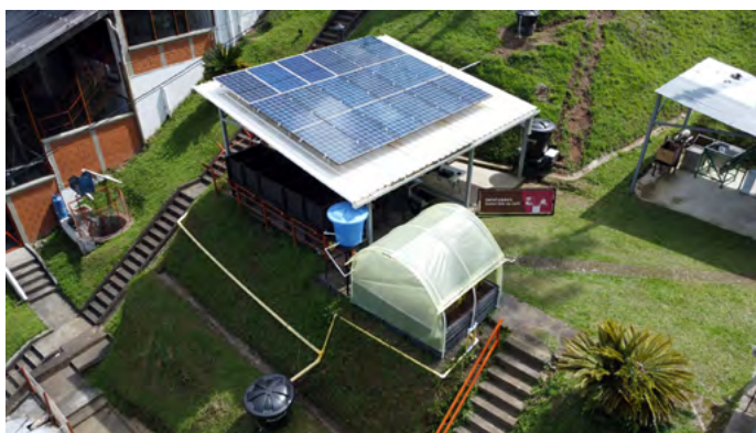
Figura 66. Beneficiadero sostenible de café con suministro de energía con paneles solares, cero vertimientos y con cosecha de aguas de lluvia para abasto.
