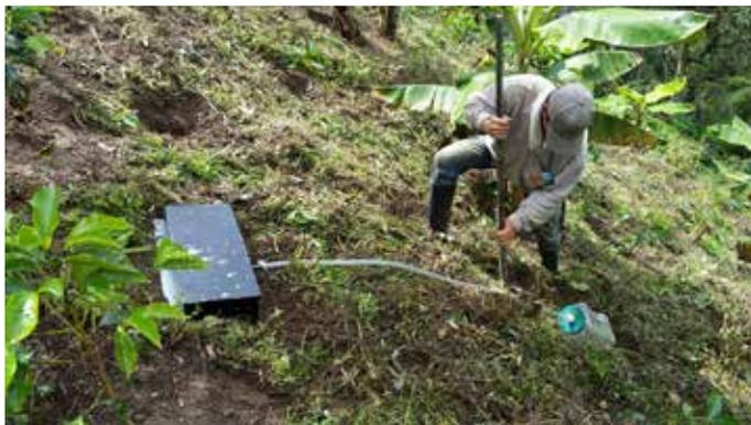
**Figura 74.** Instalación de caja colectora de sedimentos en lote vitrina de conservación de suelos.
