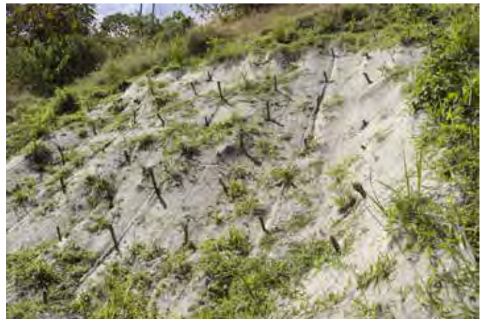
Figura 99. Cubrimiento del talud con biomanto y material vegetal. Municipio de Consacá, Nariño.
