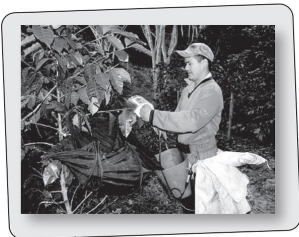
Figura 17. Equipo portátil ALFA para asistir la recolección de café, con pantalla y con “burrococo” para recibir los frutos desprendidos.
