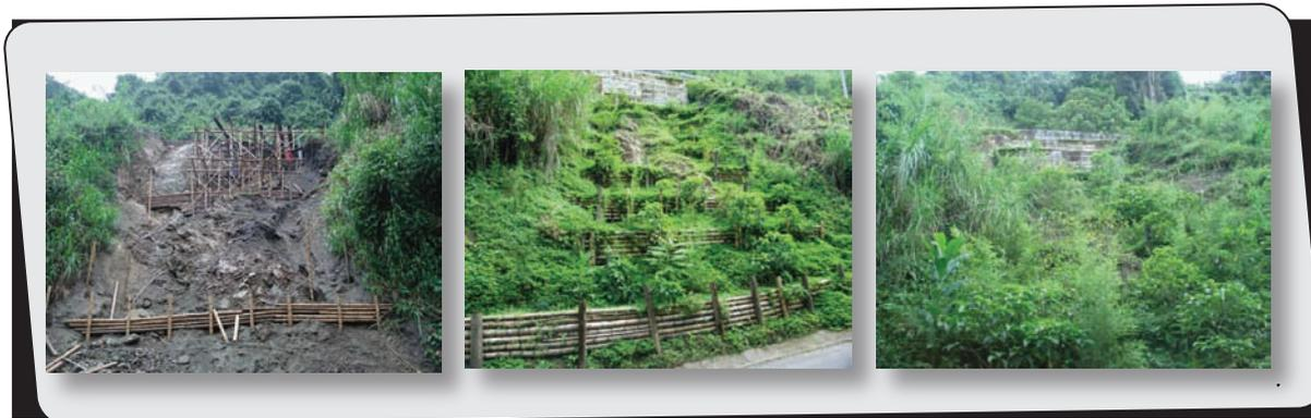
Figura 36. Secuencia de la recuperación de un talud rocoso en Cenicafé con obras biotécnicas (Desde enero 2007 a enero 2009).
