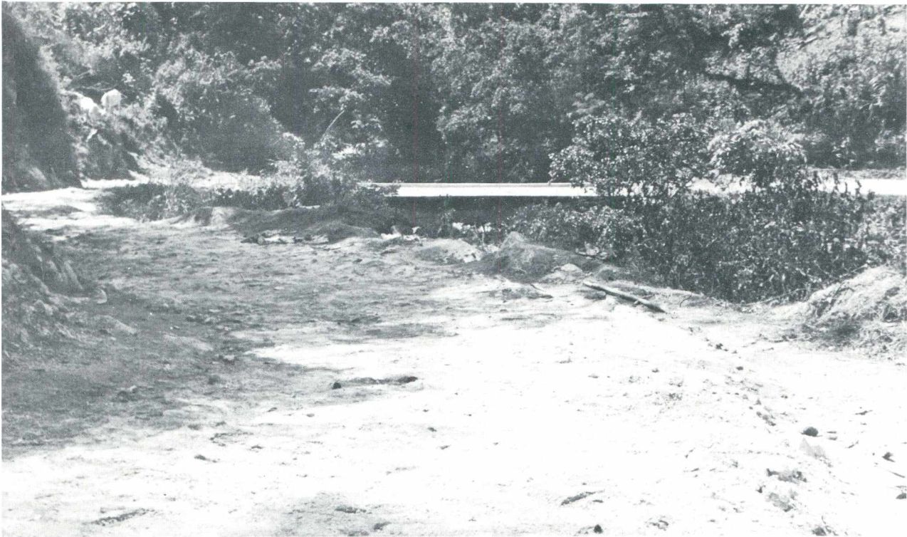
Puente sobre vía Sevilla - California.
