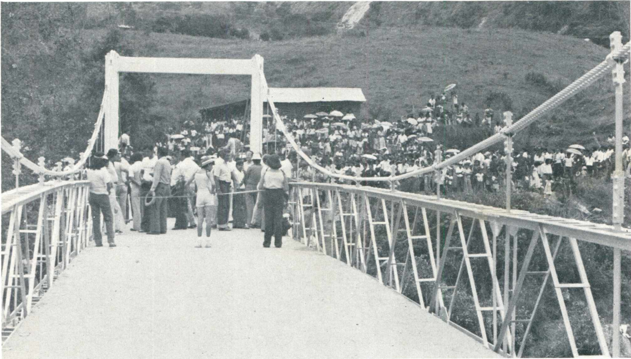
Puente sobre el río Atá - Municipio de Planadas.
