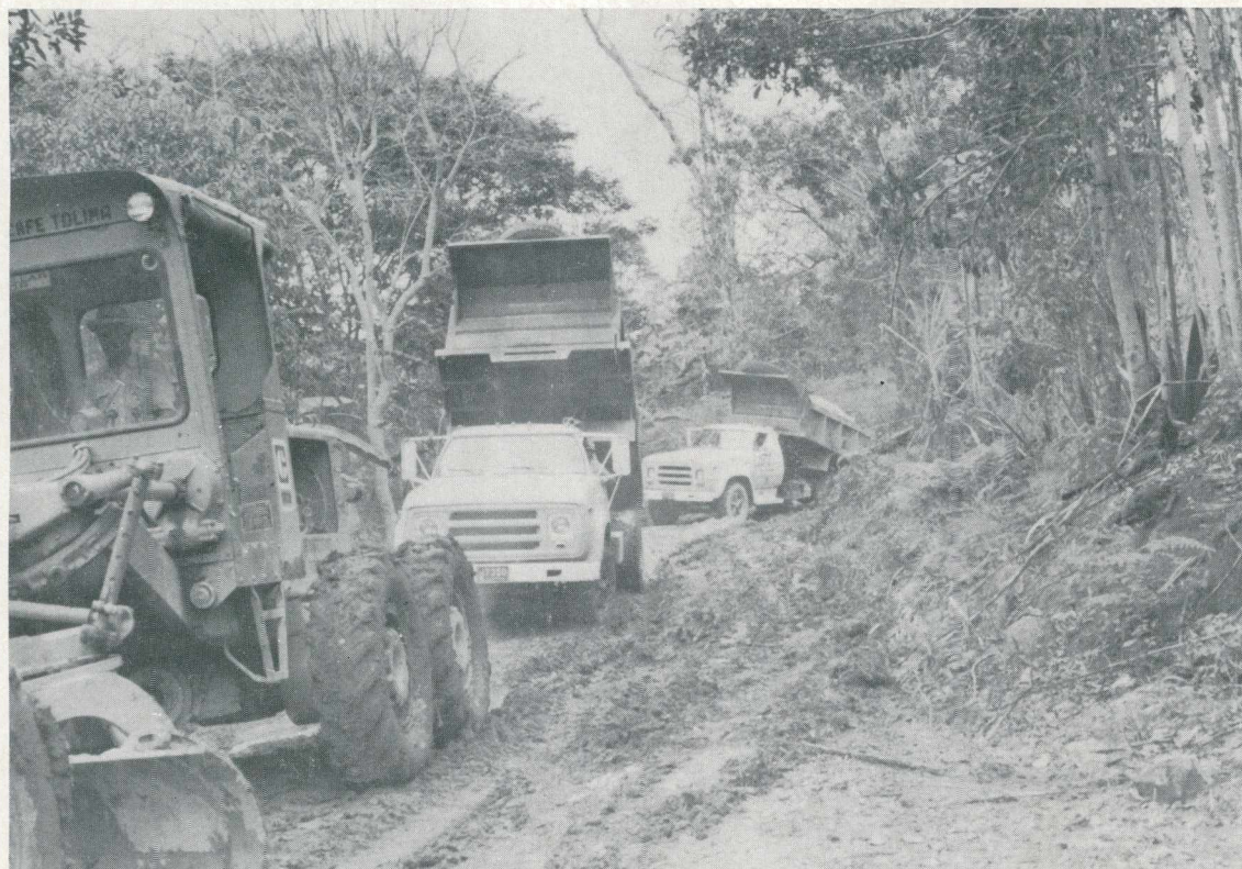
Equipo de conservación de vías.
