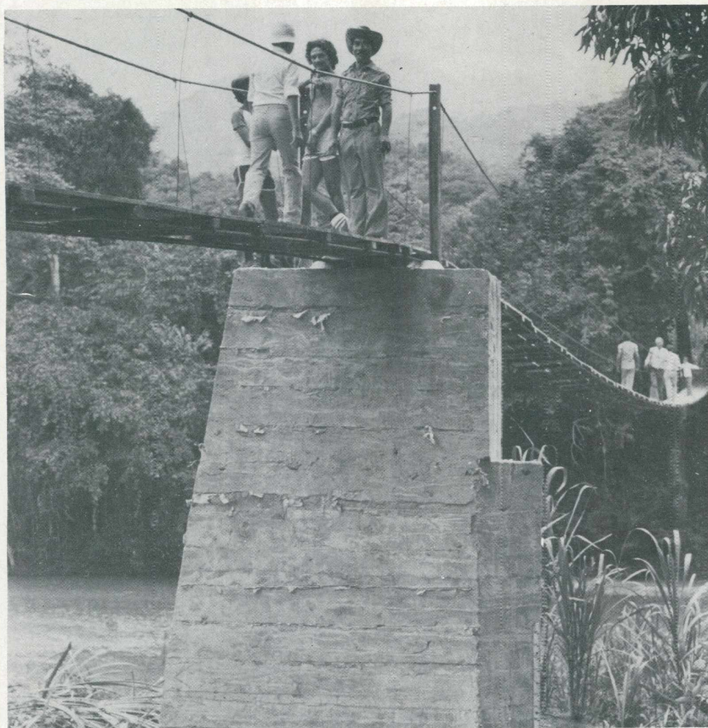
Puente La Esmeralda, río Piedras, Municipio Santa Marta
