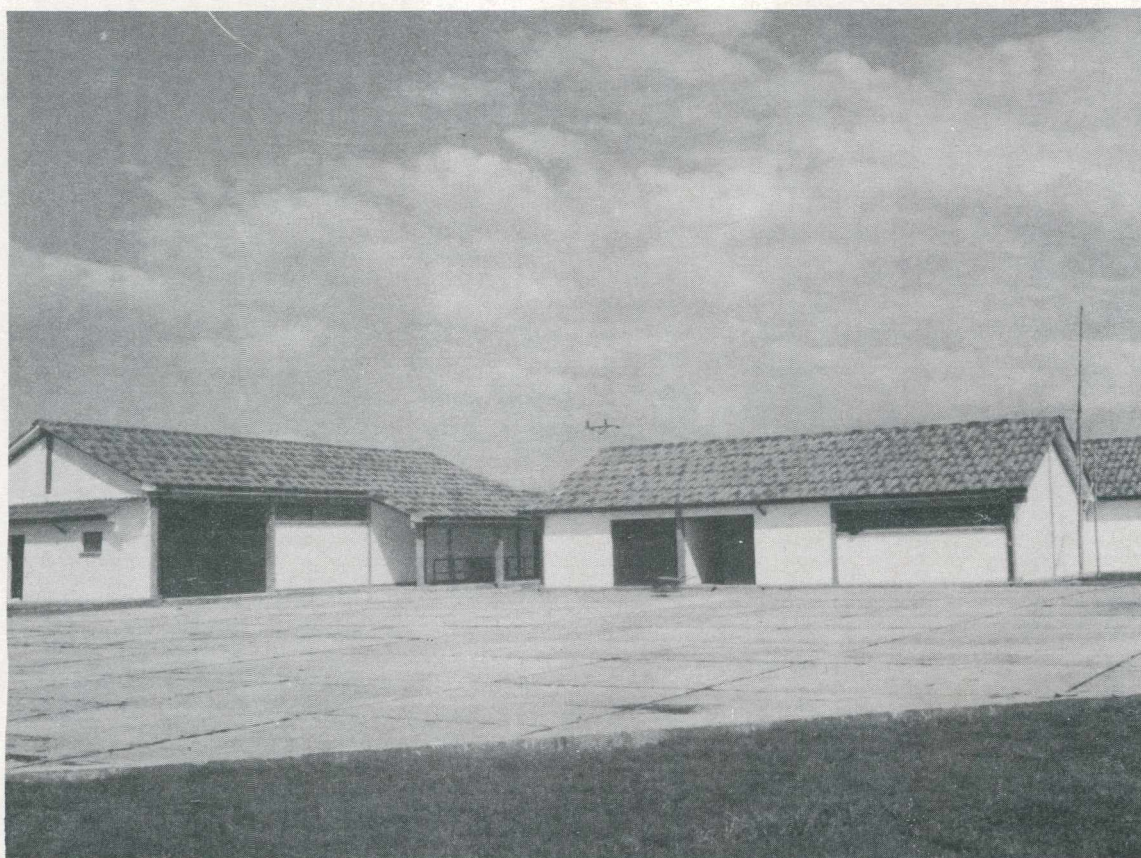
Edificio del Café. Municipio de El Tambo.
