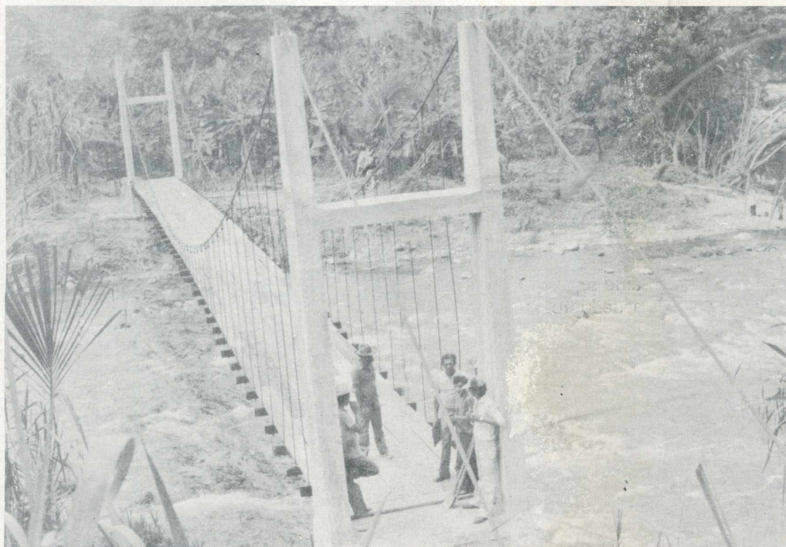
Puente colgante sobre quebrada la Tiradera, Luz: 43 mts., Vereda Guaduas, municipio de Teorama.
