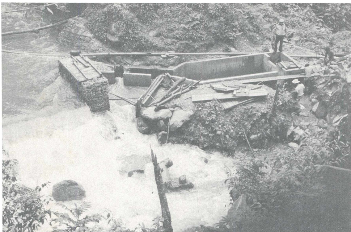
Bocatoma acueducto Andinópolis, municipio de Trujillo.
