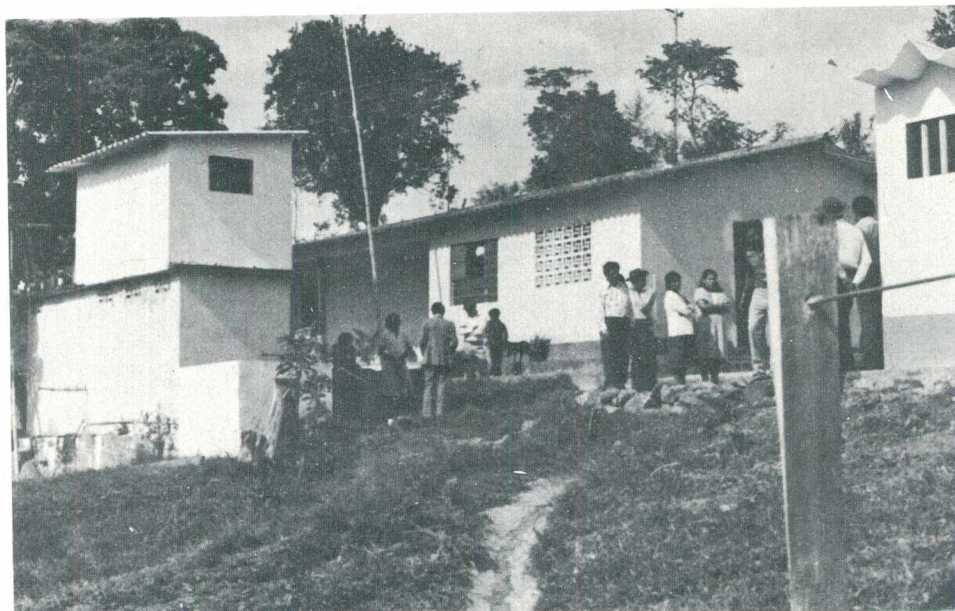
Unidad sanitaria para la Concentración Escolar La Balsa. Municipio San José de Pare.
