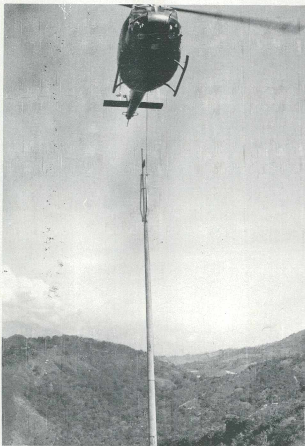
Electrificación Rural. Línea "La Esperanza—Quipile"
