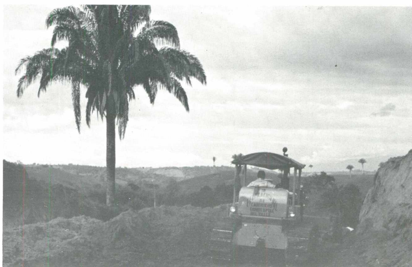
Construcción carretera Cuba—Estación Caicedonia, municipio de Caicedonia.
