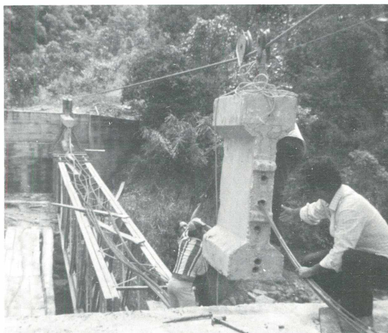
Puente para vehículos sobre el río Supatá. Luz: 32 mts.
