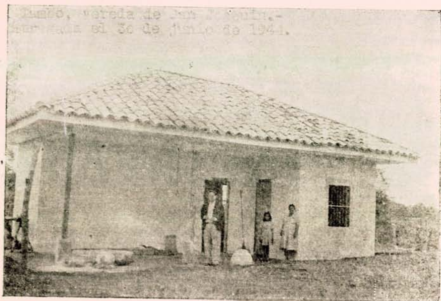
Casa construída para Demetrio Garzón, en el Municipio del Tambo, vereda de San Joaquín.—Entregada el 30 de junio de 1944.
