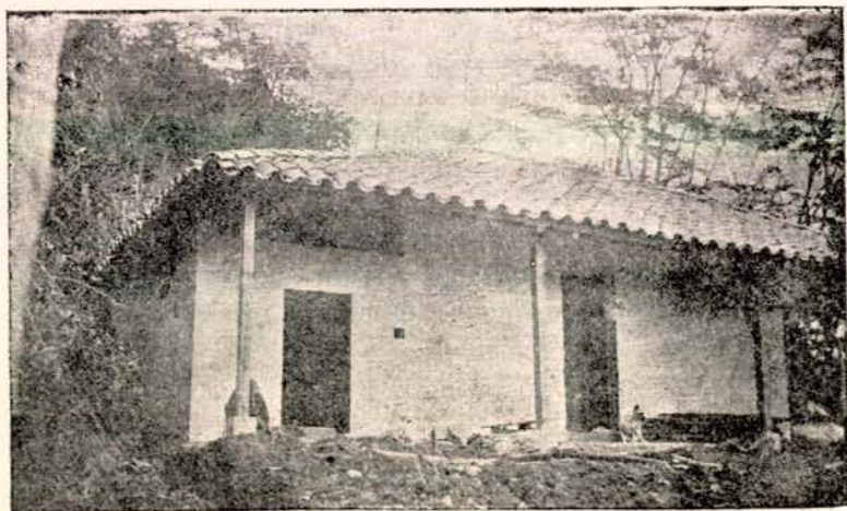
Vereda de Santa Inés, Municipio de San Vicente.—Construcción de casa y cocina de Manuel Murillo, tapia pisada, madera y teja.
