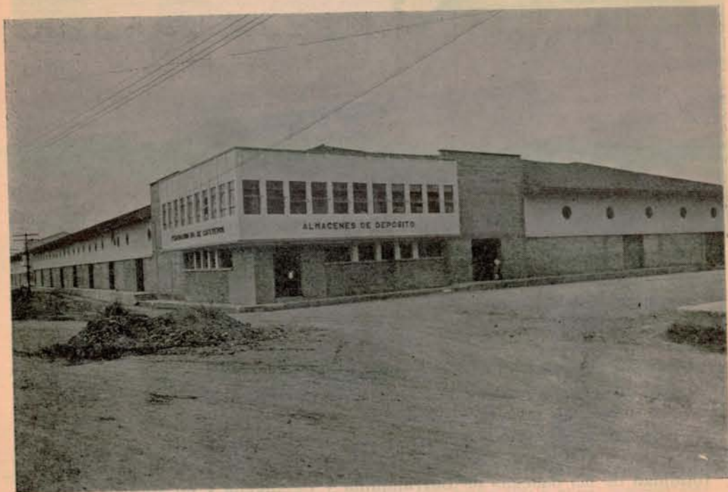
Edificio de Cali—Fachada Principal
