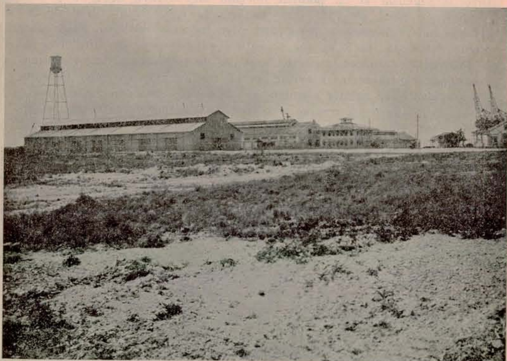
Bodega en el Terminal Marítimo de Cartagena
