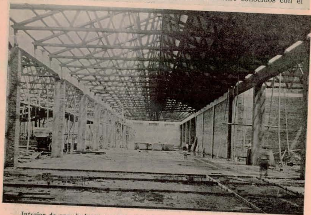
Interior de una de las naves del edificio de Girardot, en construcción
