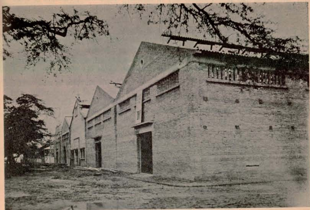
Fachada principal del edificio de Girardot, que está para terminarse
