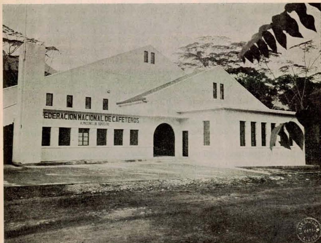
Edificio de El Líbano, para oficina y bodegas
