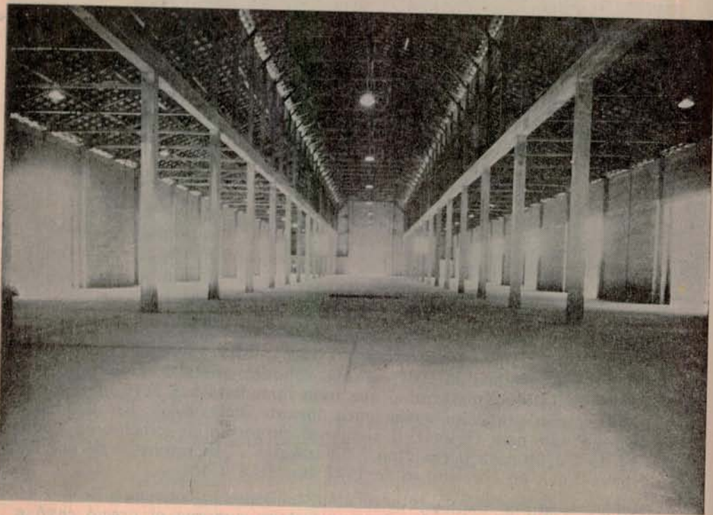
Interior de la bodega del Terminal Marítimo de Cartagena
