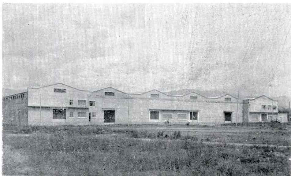
Almacenes de Tuluá
