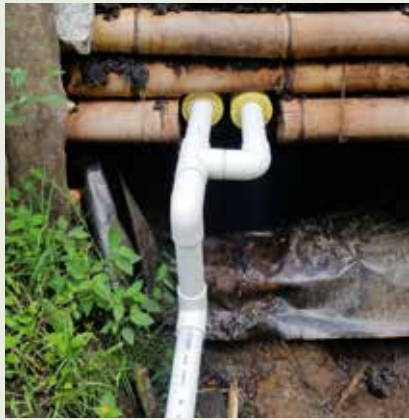
Figura 46. Canalización de los lixiviados de la mezcla pulpa-mucílago hacia el sistema de tratamiento. Estación Experimental El Tambo.
