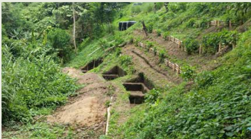
Figura 48. Sistema de tratamiento de las aguas residuales del café en la Estación Experimental Naranjal. Tratamiento secundario en un SMTA y tratamiento terciario en humedales artificiales.
