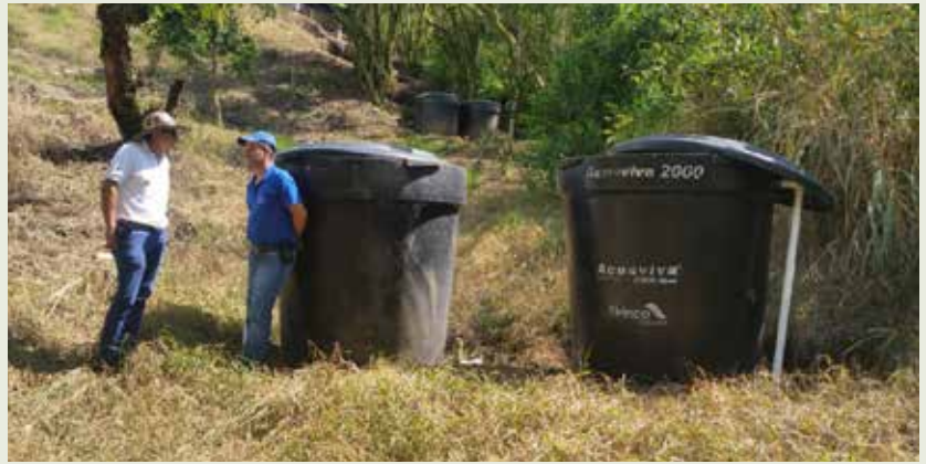
Figura 46. Canalización de los lixiviados de la mezcla pulpa-mucílago hacia el sistema de tratamiento. Estación Experimental El Tambo.
