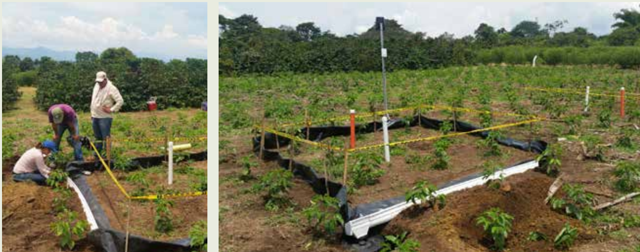
Figura 14. Construcción de las parcelas de escorrentía.
