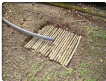
Figura 16. Excavación llena con tallos de café, para manejar sobrecargas hidráulicas o taponamientos en el sistema.
