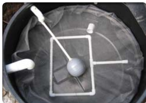
Figura 26. Dispositivos internos de la recámara dosificadora.
