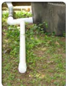
Figura 30. Dispositivo de entrada al reactor metanogénico.
