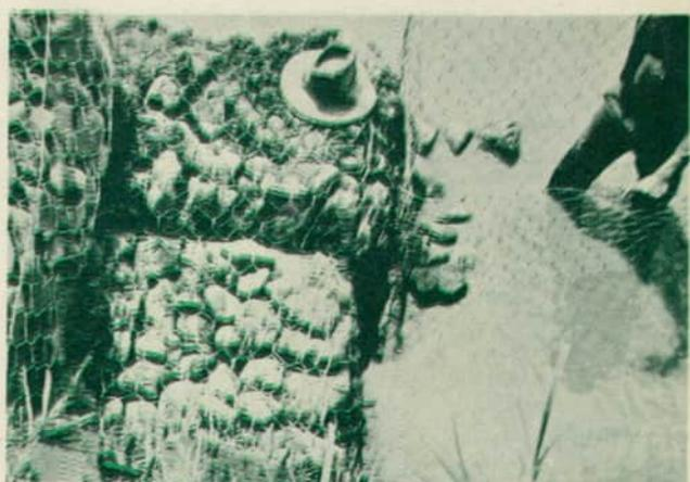
Detalle de la construcción de gaviones.
