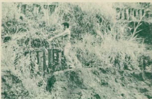
Empalizada para control de derrumbes en taludes
