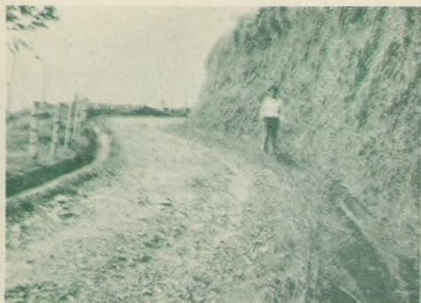
Buenas cunetas en carreteras de penetración
