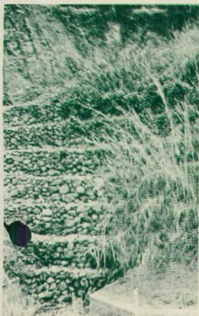
Gaviones para retención de taludes en carreteras.
