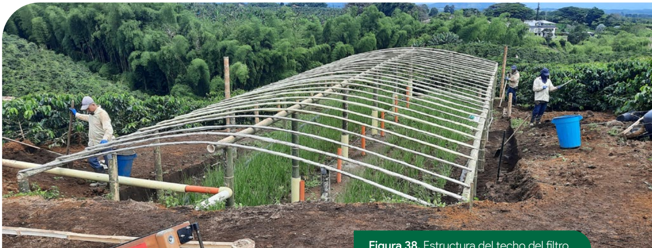
Figura 38. Estructura del techo del filtro verde elaborada en lata de guadua.
