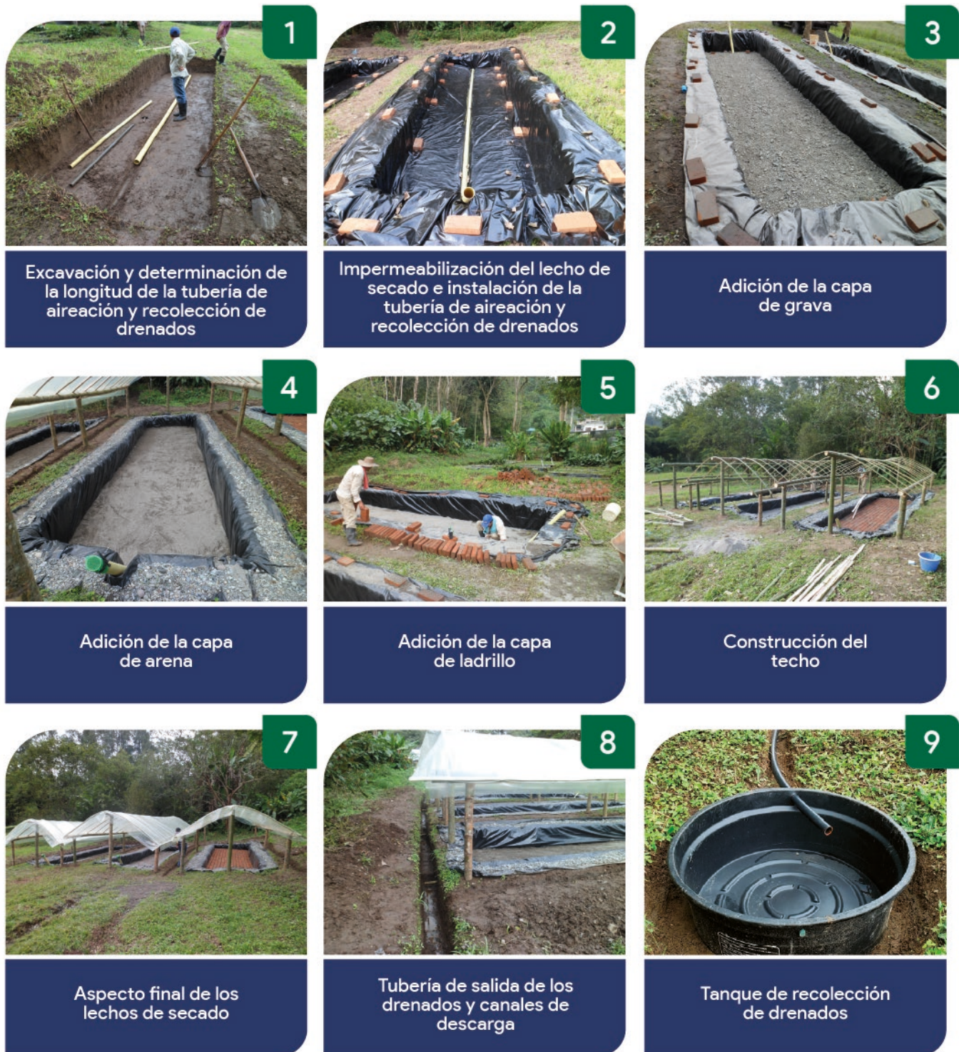
Figura 9. Construcción de un lecho de secado de lodos. Fuente: Rodríguez et al., 2022b.
