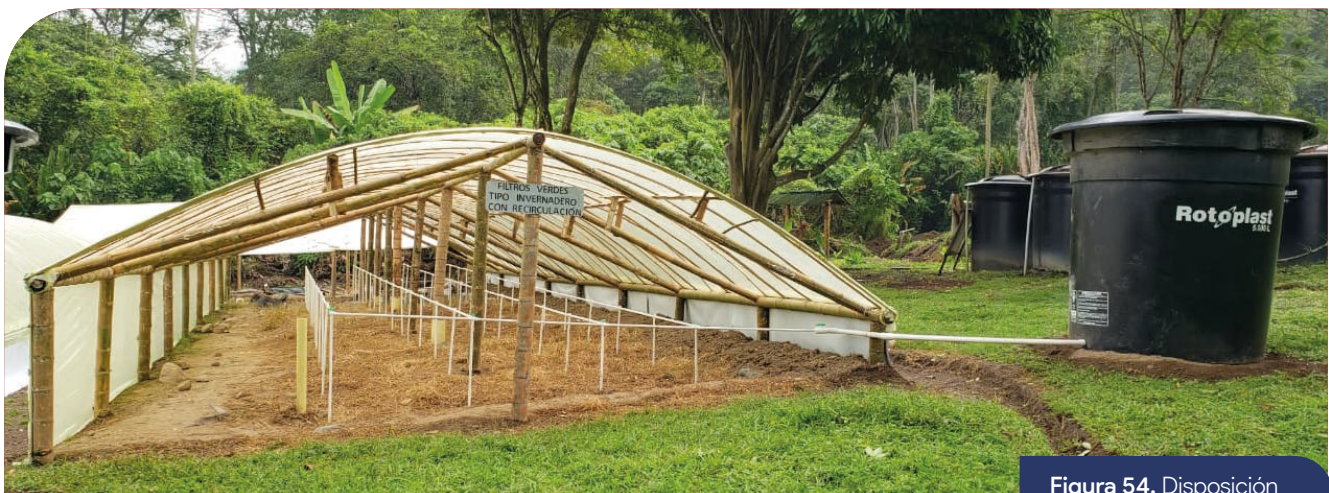
Figura 54. Disposición del tanque de aplicación.
