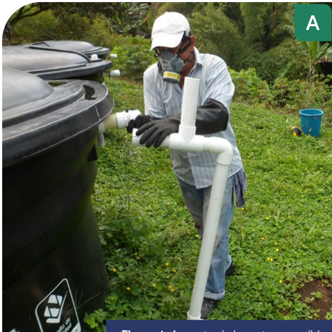
Figura 6. Aspecto de la parte removible del dispositivo de sifón invertido para la eliminación de lodos del tanque séptico. A. Acoplamiento, eliminando el tapón liso removible. B. Aspecto final de la parte removible acoplada al tanque séptico.
