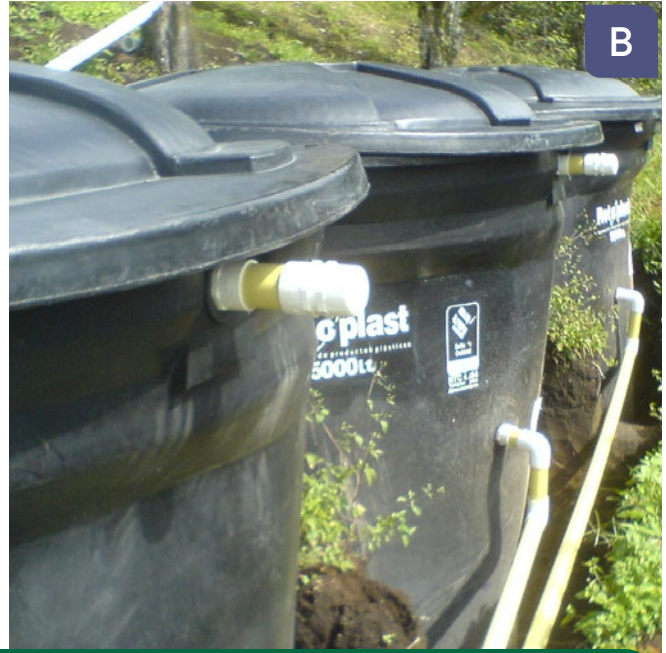
Figura 5. Aspecto de la parte fija del dispositivo de sifón invertido para la eliminación de lodos del tanque séptico. A. Instalación de la tubería interna hasta una altura de 20 cm del fondo del tanque. B. Instalación de un tapón liso removible para acoplar la parte removible del dispositivo. Fuente: Adaptado de Rodríguez et al., 2018.
