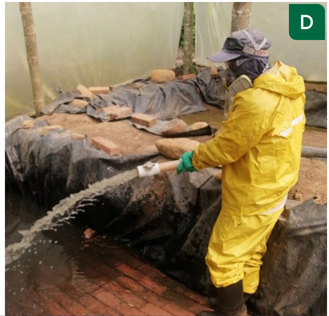
Figura 8. Aspecto de la actividad de eliminación de lodos con el dispositivo de sifón invertido. A. Aspecto del tanque séptico al momento del mantenimiento. B. Purga del sistema utilizando agua de grifo. C. Aspecto del lodo eliminado del tanque séptico. D. Aspecto del agua y como ésta se va aclarando, indicando la finalización de la actividad.
