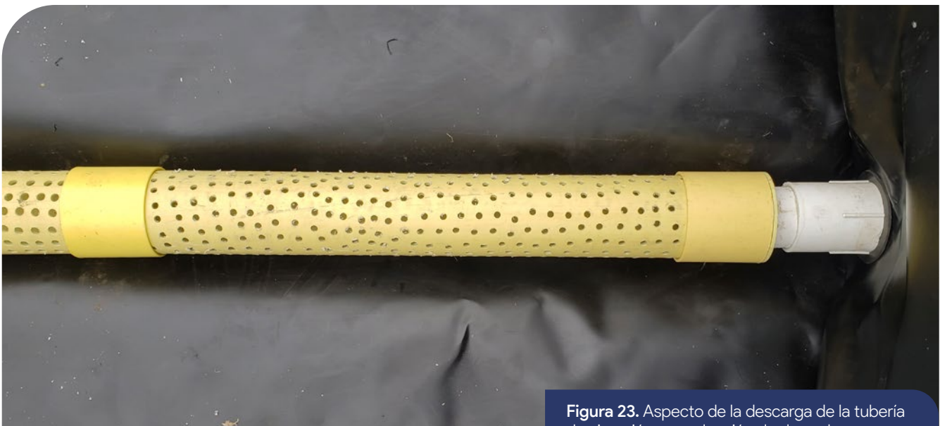
Figura 22. Accesorios en el extremo de descarga de la tubería de conducción de drenados.
