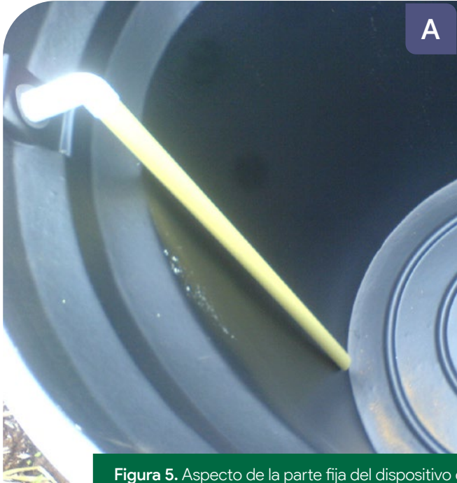
Figura 5. Aspecto de la parte fija del dispositivo de sifón invertido para la eliminación de lodos del tanque séptico. A. Instalación de la tubería interna hasta una altura de 20 cm del fondo del tanque. B. Instalación de un tapón liso removible para acoplar la parte removible del dispositivo. Fuente: Adaptado de Rodríguez et al., 2018.
