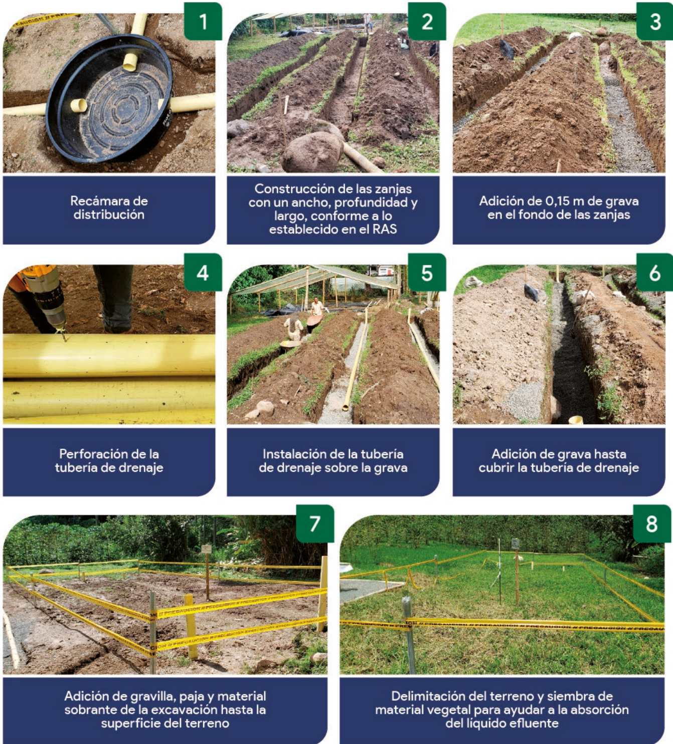
Figura 13. Aspecto de la construcción de un campo de infiltración Fuente: Rodríguez et al., 2022b.
