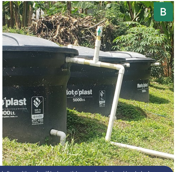
Figura 6. Aspecto de la parte removible del dispositivo de sifón invertido para la eliminación de lodos del tanque séptico. A. Acoplamiento, eliminando el tapón liso removible. B. Aspecto final de la parte removible acoplada al tanque séptico.
