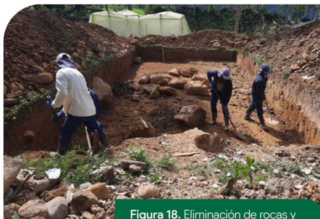
Figura 18. Eliminación de rocas y materiales contrapuzantes de la excavación.
