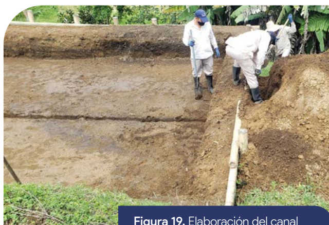
Figura 19. Elaboración del canal central con salida afuera de la excavación.
