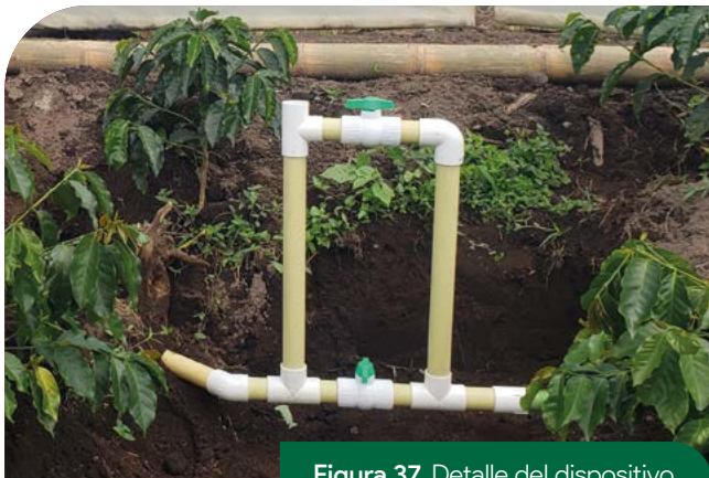
Figura 37. Detalle del dispositivo de control de inundación.
