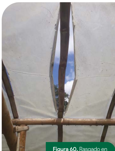
Figura 60. Rasgado en la cubierta plástica.
