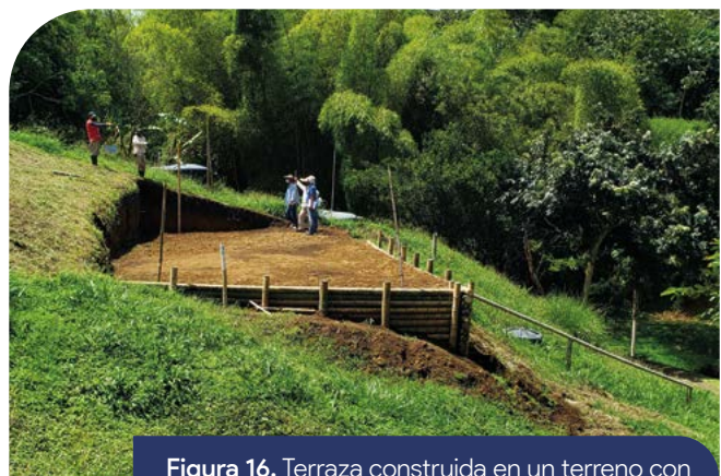
Figura 16. Terraza construida en un terreno con pendiente para la instalación del filtro verde.
