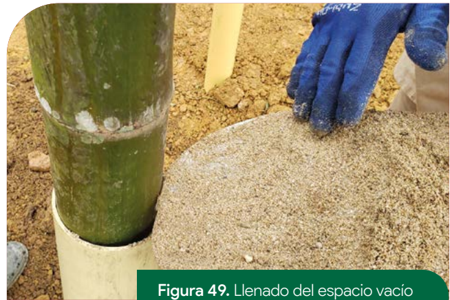
Figura 48. Base en PVC-S, enterrada en el suelo del filtro verde, en cuyo interior se ubica la columna que ayuda a soportar el techo.
