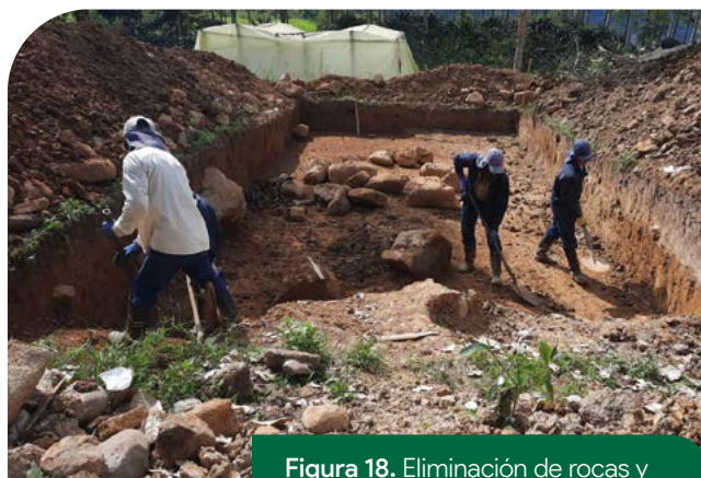
Figura 17. Excavación de 0,70 m de profundidad para la construcción del filtro verde.
