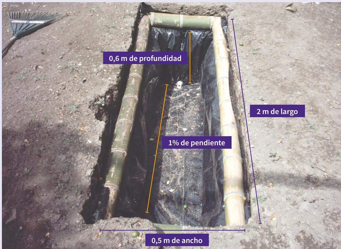
**Figura 23.** Aspecto de una celda, de 1 m<sup>2</sup>, de un humedal, que puede operar sin grava (SHFL) y con grava (SHFS). Fuente: Rodríguez (2009).
