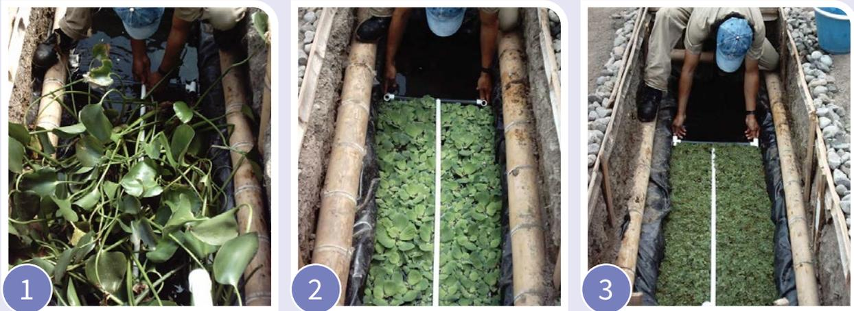
**Figura 25.** Densidad inicial de las plantas flotantes, cubriendo el 50% del espejo de agua en los humedales artificiales horizontales de flujo superficial. 1. Siembra del jacinto de agua; 2. Siembra de la lechuga de agua; 3. Siembra de la oreja de agua. *Fuente: Rodríguez (2009).*
