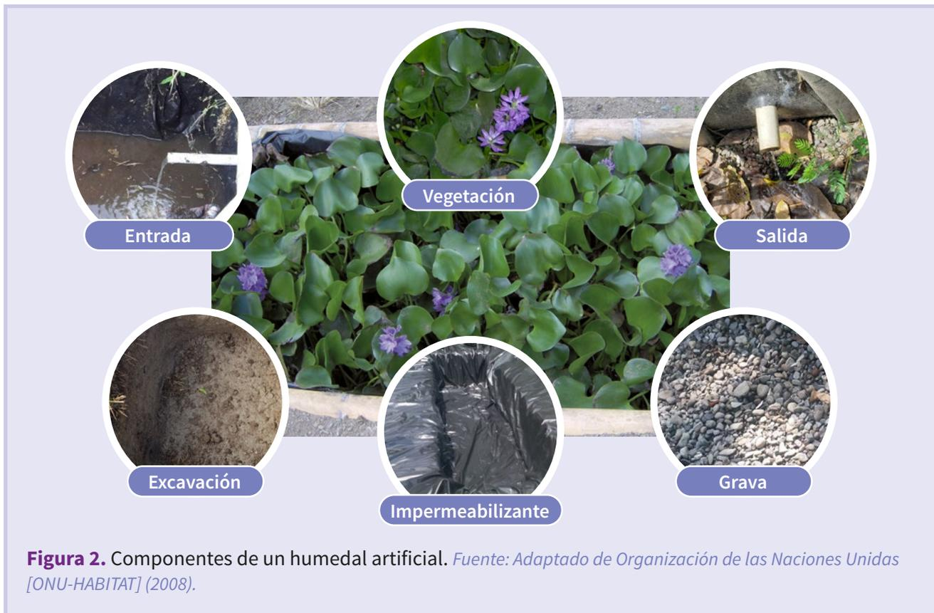
**Figura 2.** Componentes de un humedal artificial. Fuente: Adaptado de Organización de las Naciones Unidas [ONU-HABITAT] (2008).
