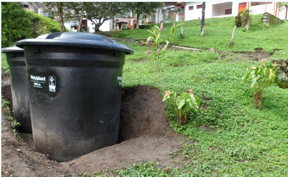
**Figura 36.** Sistema séptico instalado en la Estación La Granja, conformado por un tanque séptico de 5 m<sup>3</sup> y un filtro anaerobio de flujo ascendente de 5 m<sup>3</sup>.
