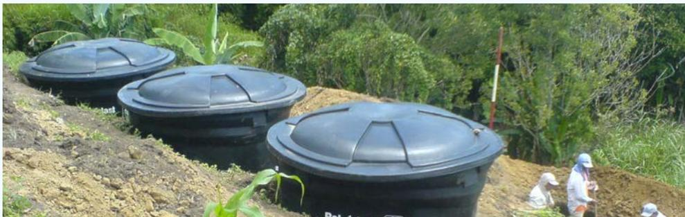
**Figura 15.** Tanques sépticos semienterrados, instalados en paralelo, en la Estación Experimental Naranjal. *Fuente: Rodríguez et al. (2018b).*
