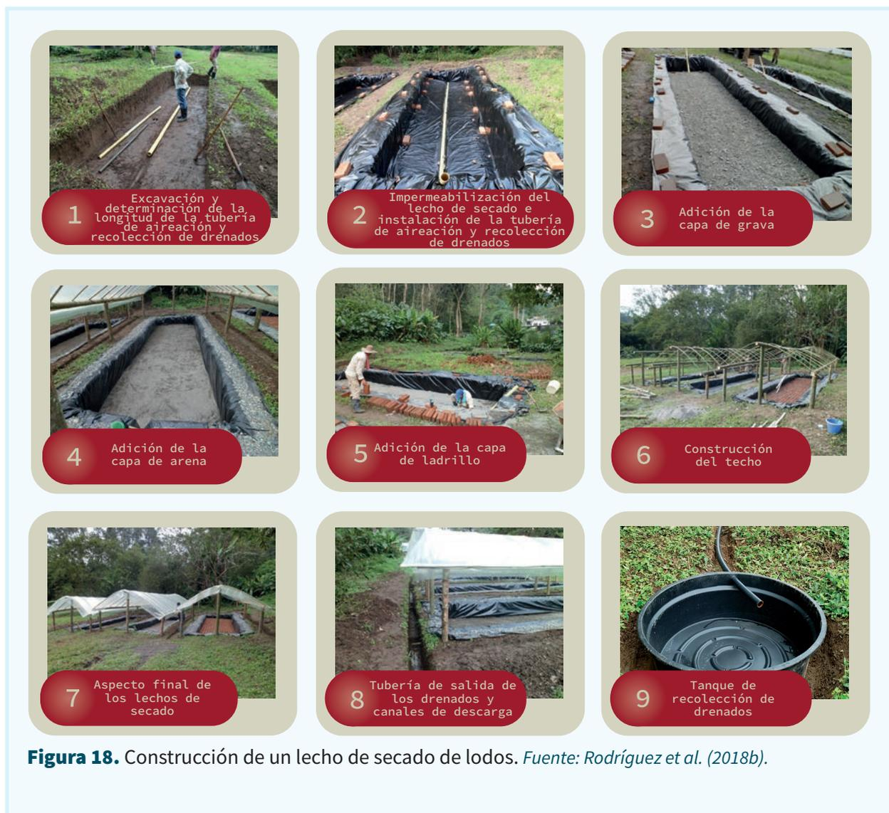
**Figura 18.** Construcción de un lecho de secado de lodos. Fuente: Rodríguez et al. (2018b).
