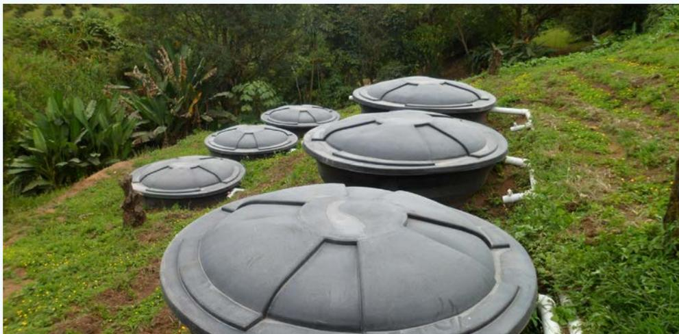
**Figura 34.** Sistema séptico instalado en la Estación Experimental Naranjal, conformado por tres tanques sépticos de 5 m<sup>3</sup> y tres filtros anaerobios de flujo ascendente de 5 m<sup>3</sup>.
