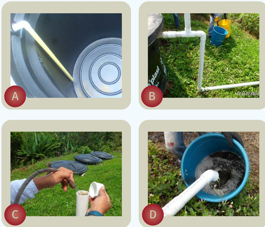
**Figura 17.** Dispositivo de eliminación de lodos del tanque séptico A. Tubo interno 20 cm por encima del fondo del tanque. B. Acople del dispositivo externo de conducción de lodos. C. Purga del dispositivo utilizando agua. D. Aspecto de los lodos extraídos. *Fuente: Rodríguez et al. (2018b).*
