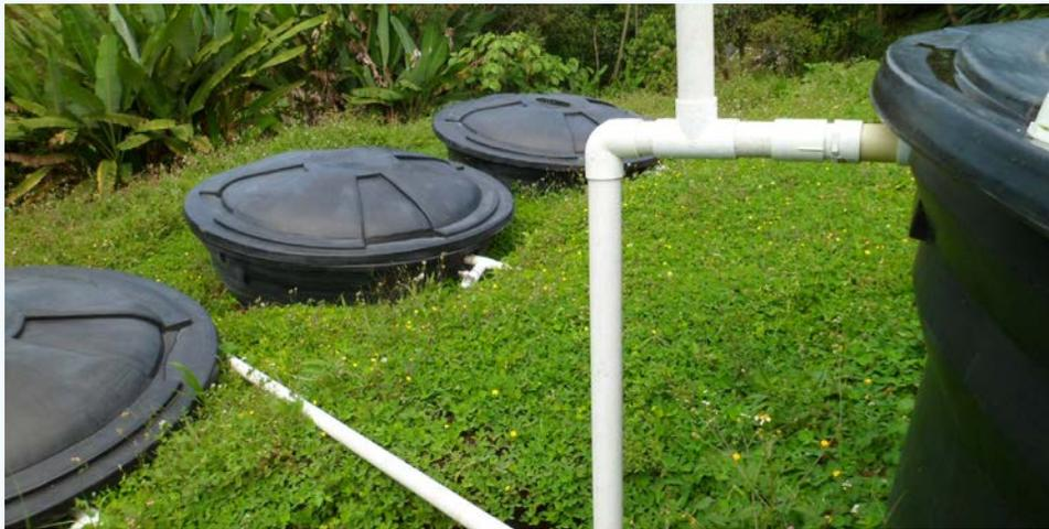
**Figura 16.** Dispositivo de sifón invertido para la eliminación de lodos del tanque séptico. *Fuente: Rodríguez et al. (2018b).*
