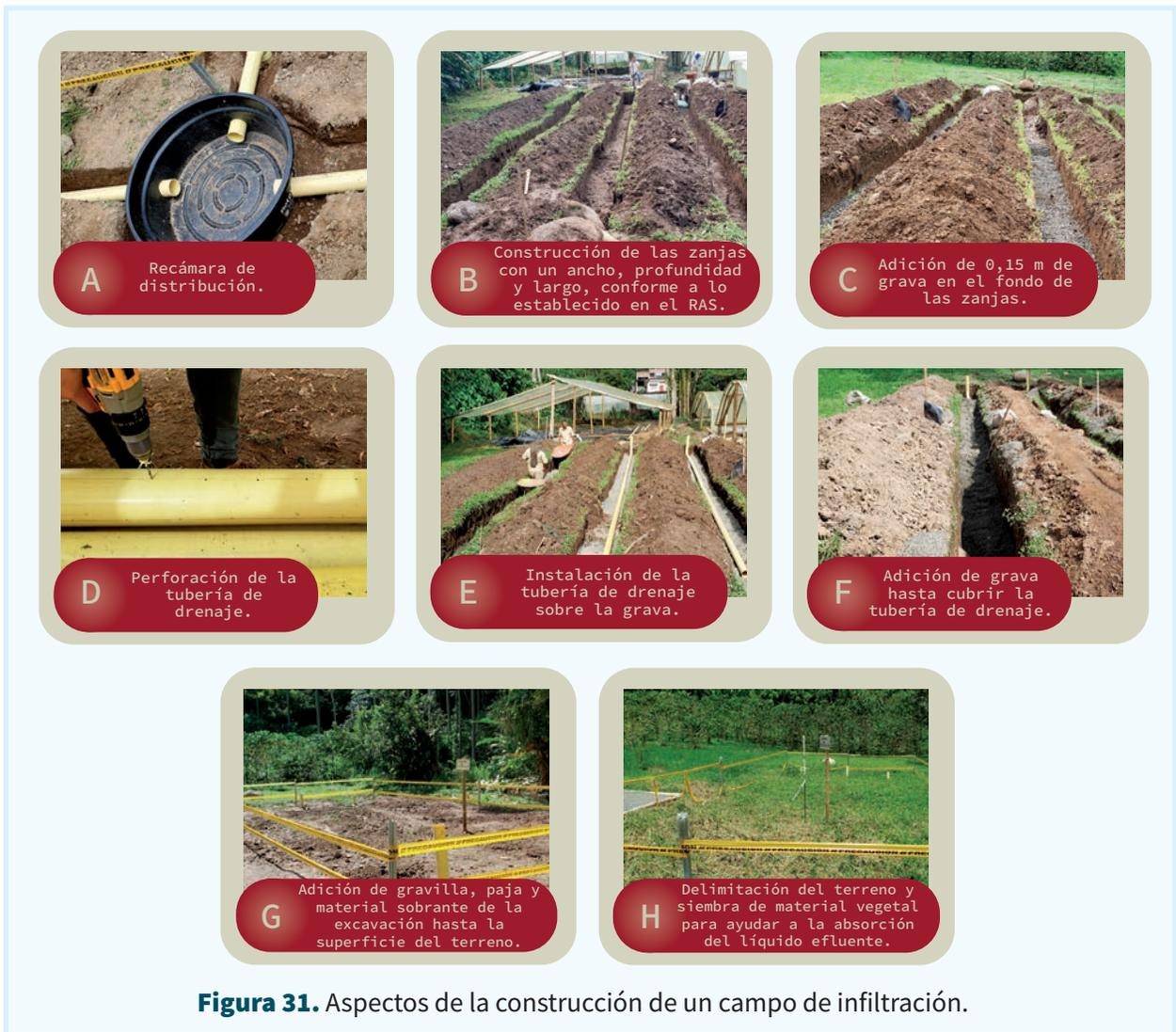
**Figura 31.** Aspectos de la construcción de un campo de infiltración.
