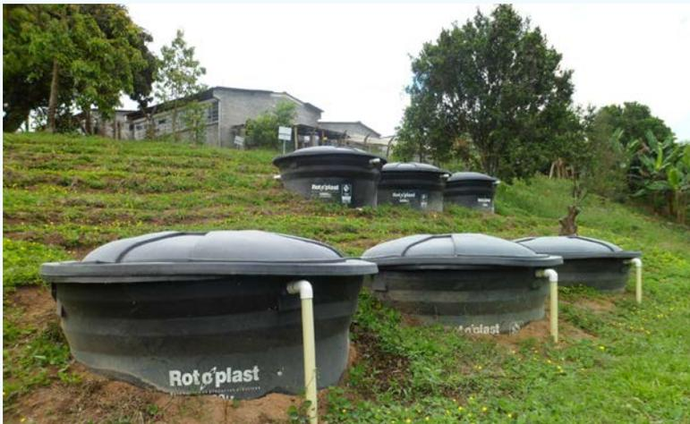
**Figura 21.** FAFAs semienterrados, instalados en paralelo, en la Estación Experimental Naranjal.
