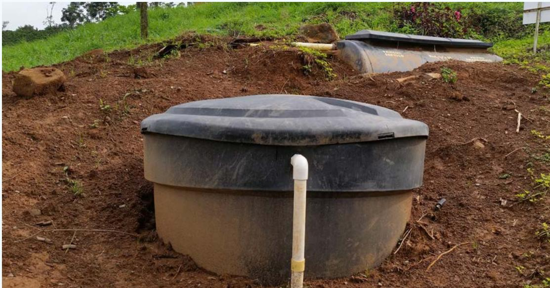
**Figura 37.** Sistema séptico instalado en la Estación El Rosario, conformado por un tanque séptico de 5 m<sup>3</sup> y un filtro anaerobio de flujo ascendente de 5 m<sup>3</sup>.
