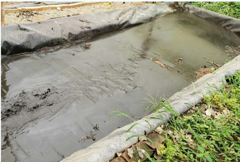
**Figura 38.** Aspecto de los lodos retirados del tanque séptico y dispuestos en los lechos de secado.
