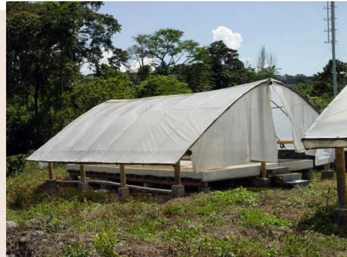
**Secador solar parabólico tipo Cenicafé**
