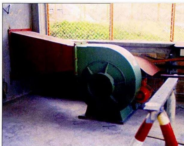
**Figura 95.** Ventilador centrífugo forzando aire a un silo-secador CENICAFÉ. Obsérvese la correcta transición entre la salida del ventilador y la entrada al secador (el generador de aire caliente ha sido retirado).
