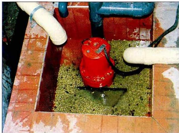
**Figura 26.** Motobomba sumergible utilizada para el lavado y transporte del café.
