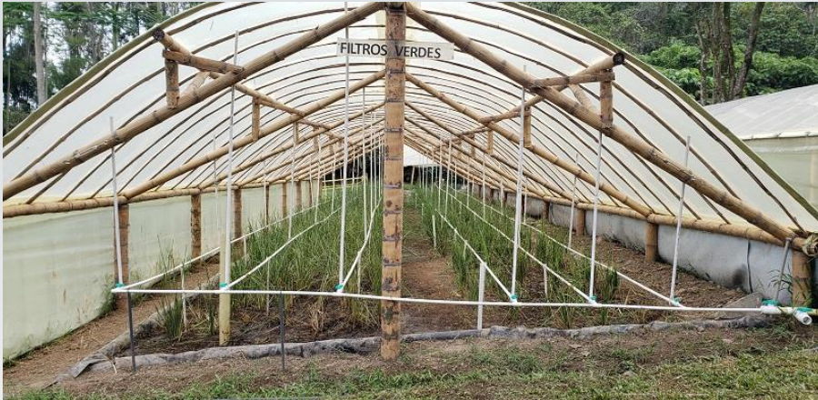
7. Instalación del sistema de riego
