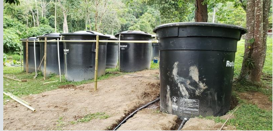
6. Canalización del agua del SMTA al FV
