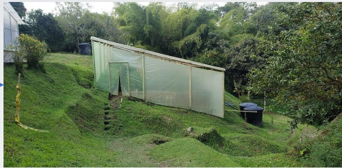
Filtro Verde Estación Naranjal. 65 m 2
