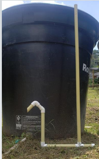
Dispositivo de descarga de agua residual evaluada
