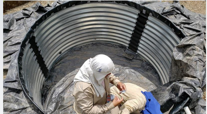
8. Instalación del tanque de drenados
