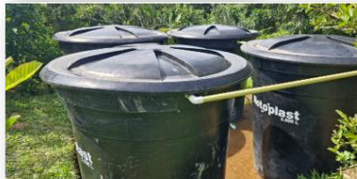
Instalación del sistema de almacenamiento, bombeo y distribución
