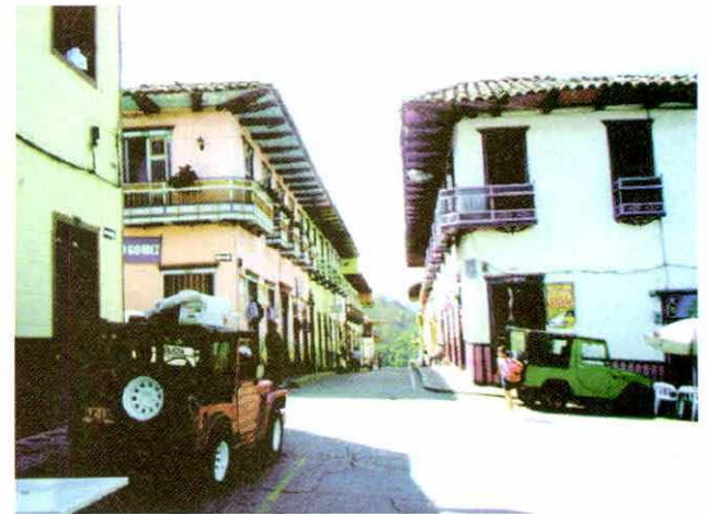
Foto 1.30. Calle Real de Santuario tras la recuperación de las carpinterías de madera.
