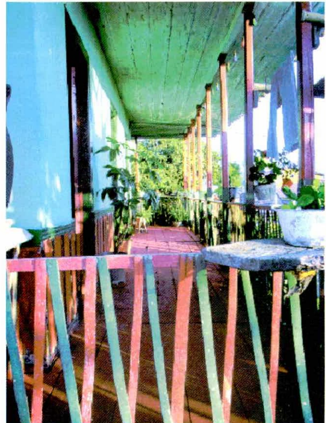
Foto 1.39. Corredor, finca Villa Flor, municipio de Pereira.
