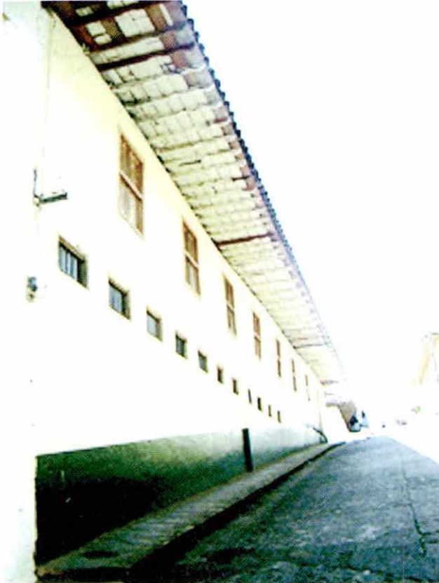
Foto 1.8. Fachada de la escuela Valentín Garcés, Apía
