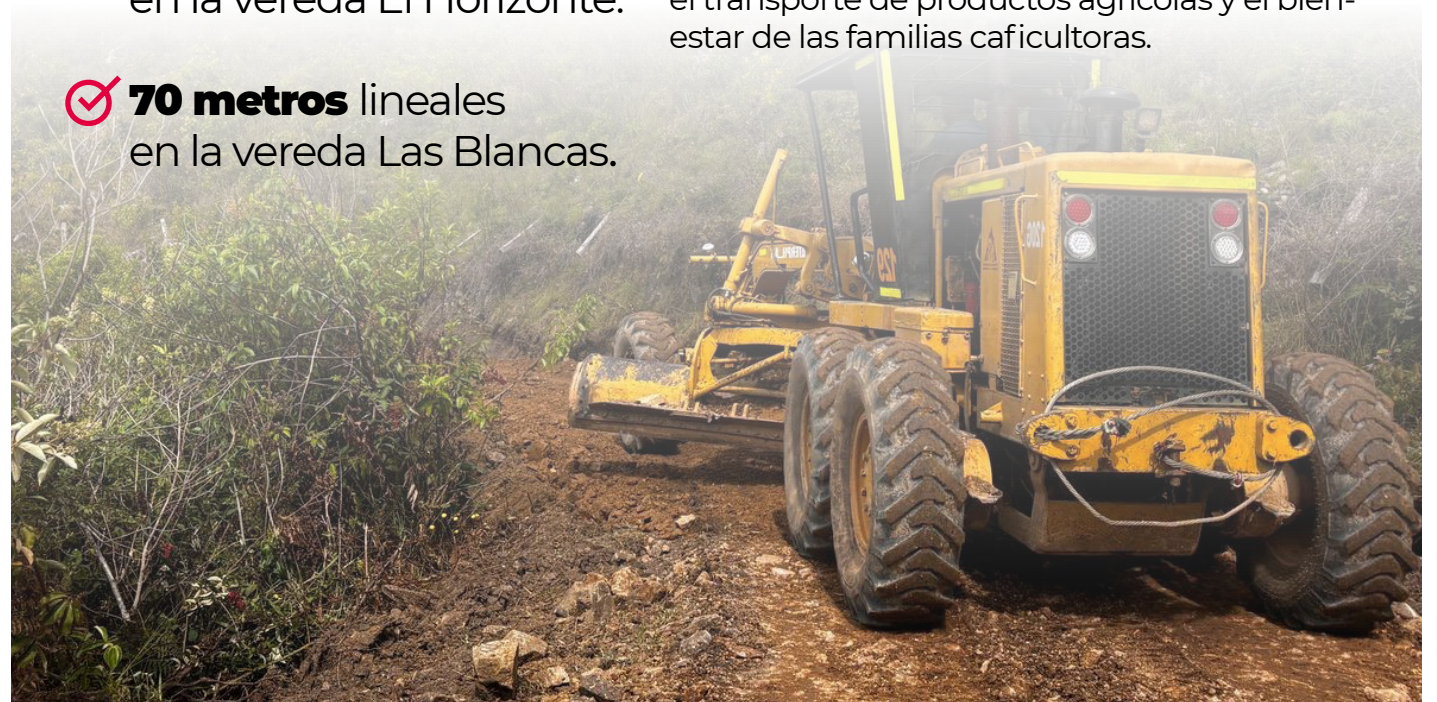
Intervención de vías - Roncesvalles
