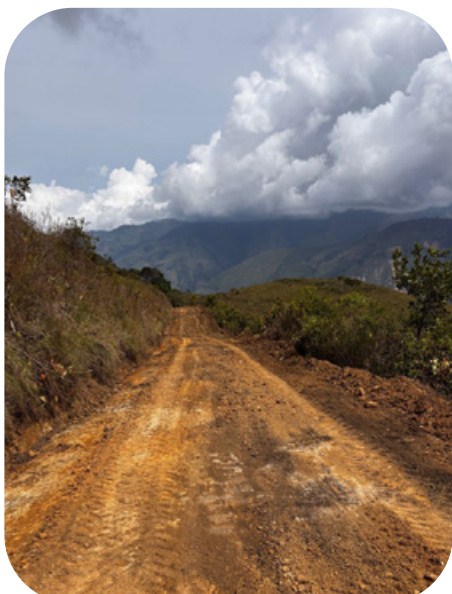
Intervención de vías Roncesvalles
