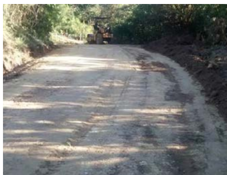
Vía Japón-Llanitos parte alta, Dolores.
