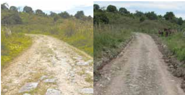
Vía Villarrica - Tres Esquinas Antes
